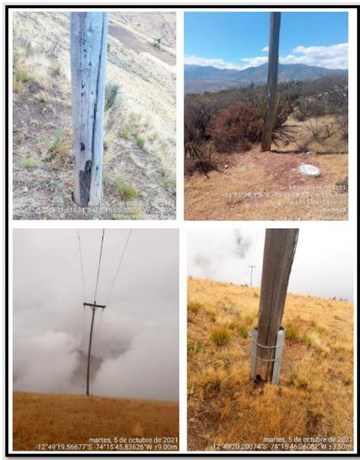
Fig. 2. Postes de madera de media tensión deteriorada
