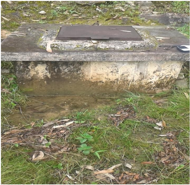
Fotografía N° 01. Reservorio Existente en mal estado de onservación con grietas en lasparedes del reservorio.
