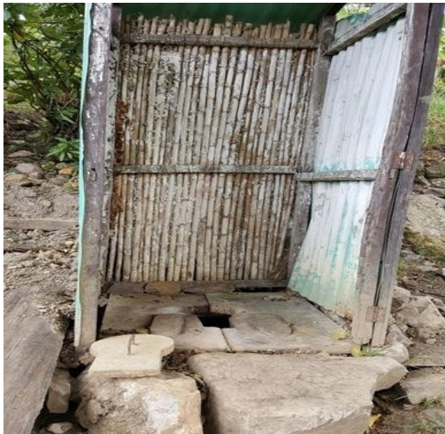
Fotografía 4. Letrina con pozo ciego en mal estado de conservación, sin caseta adecuada, tubería de ventilación y losa
