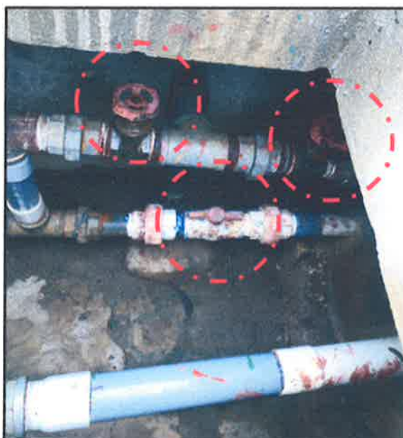
FOTOGRAFIA 4: Interior de la caseta, válvulas deterioradas
