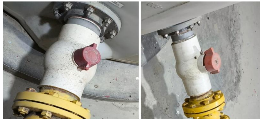
Imagen N° 3. Válvulas de PVC tipo bola de 4" Ø
