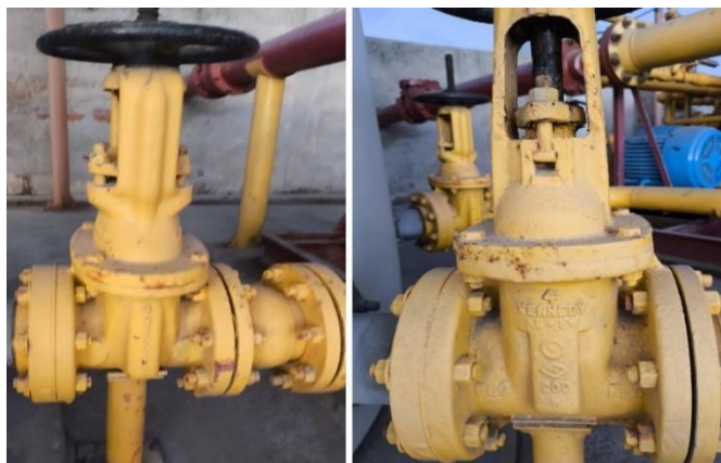
Imagen N° 4. Válvulas de acero al carbono bridada tipo compuerta de 4" Ø
