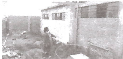
Fotos 22.- vista posterior de los servicios higiénicos de los niños, se puede observar el ataque de la humedad del suelo al sobrecimiento y a la pared.
