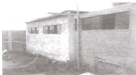
Foto 10. - visto posterior del aula 1 se observa la humedad del suelo que esta atacando al concreto del sobrecimiento y el muro de ladrillo.
