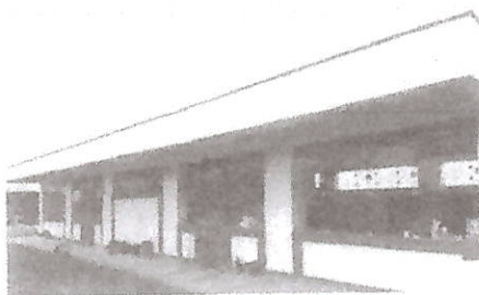
Foto 9. - visto frontal del aula 03 y04 existente, construido por la municipalidad de Quilmaná en el año 2018 con paredes de ladrillo, techo de losa aligerada y piso de porcelana con estado de conservación buena.
