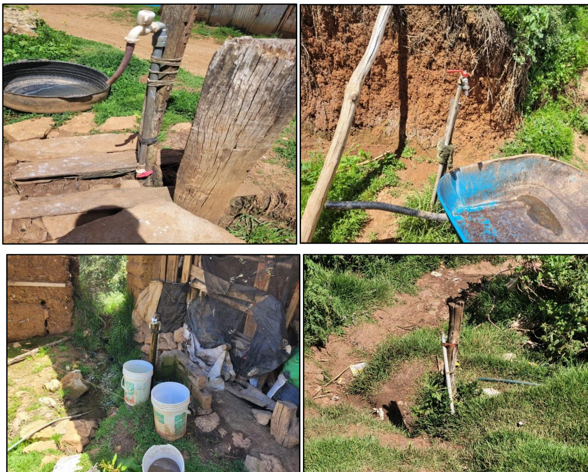
FOTOGRAFIA N° 18,19,20 y 21: Conexión domiciliar de agua en Cceñuacucho.
