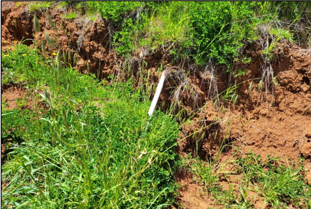
FOTOGRAFIA N° 17: TUBERIA TUBERIA EXPUESTO AL AIRE LIBRE
