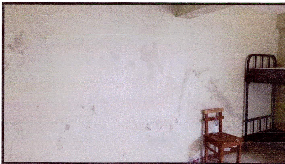
Fotografía 03: Descascaramiento de pintura, falta resane de la pared parte posterior.
