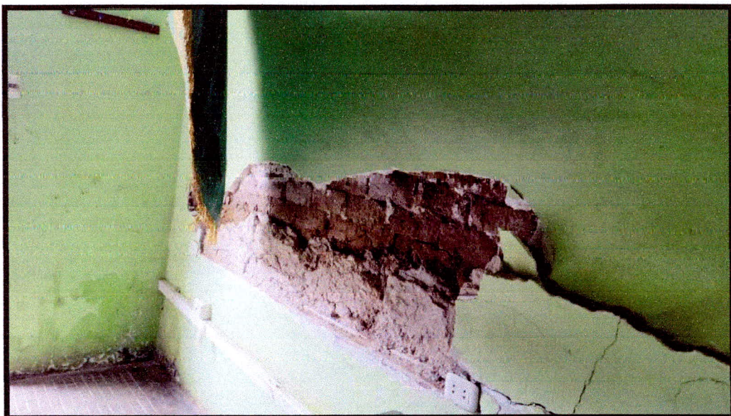
Fotografía 06: Resane de pared y pintado debido a su mal estado.
