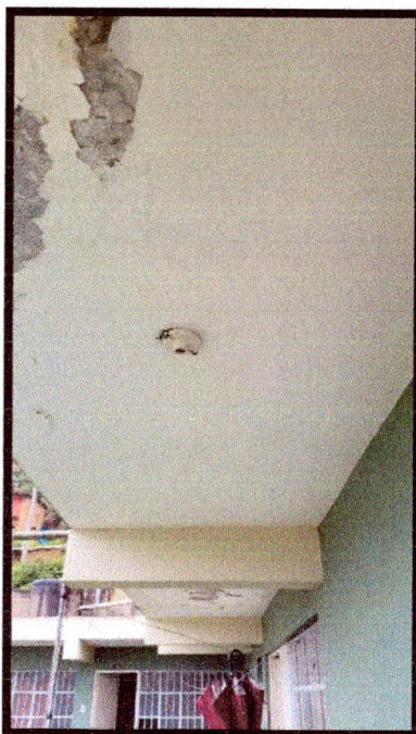
Fotografía 02: Filtraciones del techo, descascaramiento de pintura falla de luminarias.
