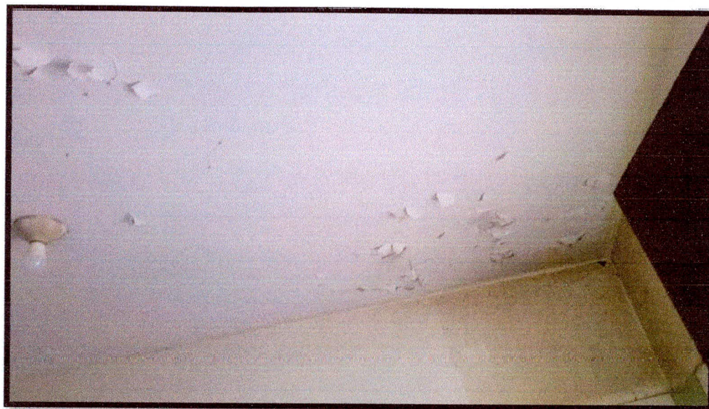
Fotografía 01: Techo en mal estado, por filtración de la losa aligerada.
