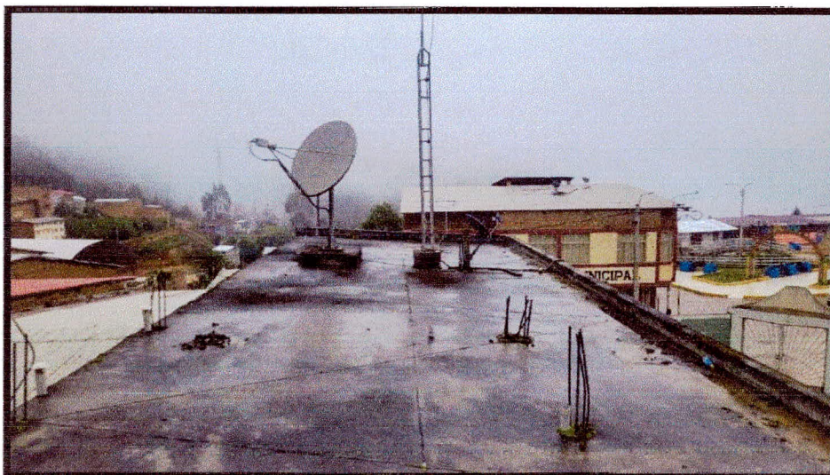
Fotografía 04: Techo sin cobertura lo que hace filtrar a todo el techo del segundo piso.
