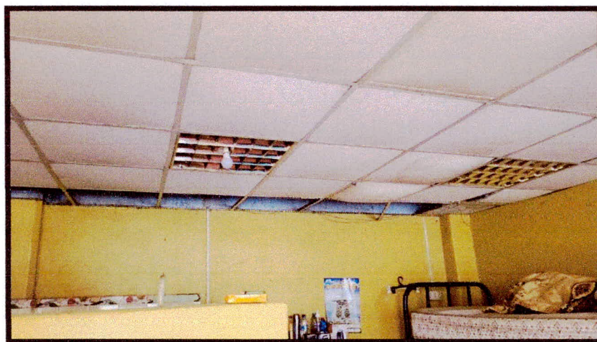
Fotografía 04: Reposición de baldosas de yesos de 0.60m x 0.60m, e instalación de luminarias adosables de 0.60m x 0.60m.
