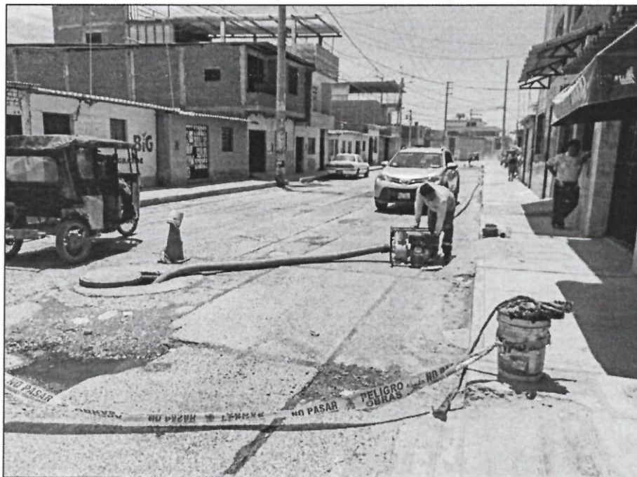
Ilustración 5: Tramo colapsado y trasvase realizado para evitar afloramientos.
