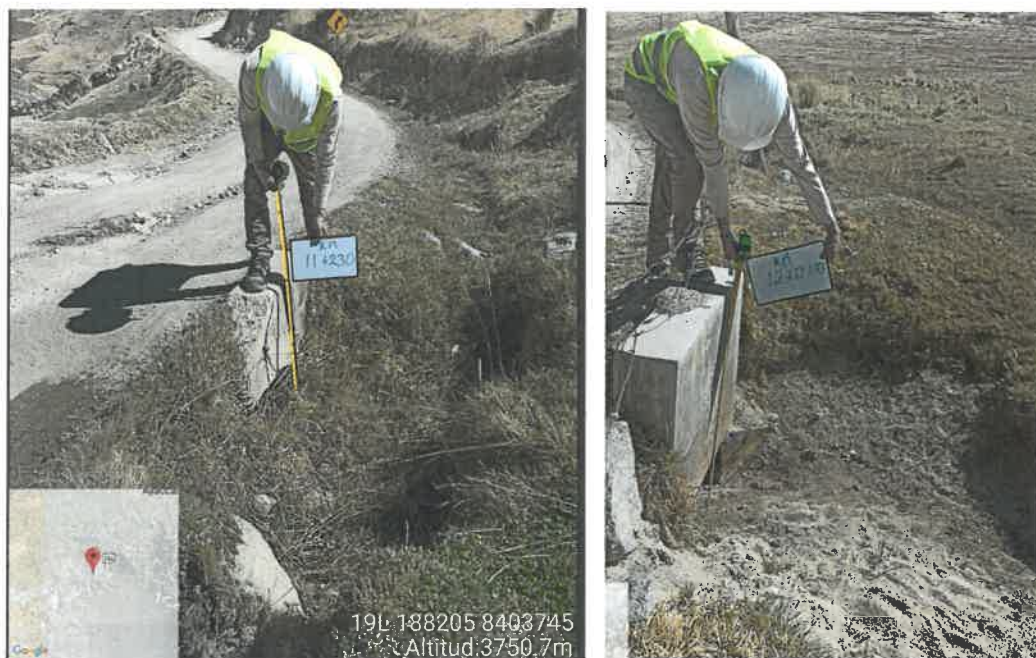
Ilustración 7 Alcantarillas obstruidas y semiobstruidas
