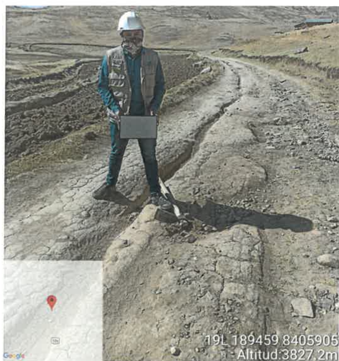
Ilustración 2 Tramo critico causado por Erosión
