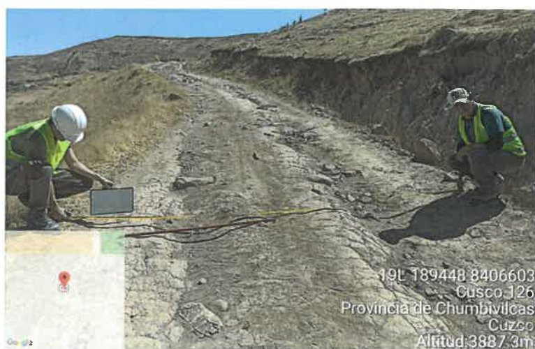
Ilustración 3 Tramo critico causada por erosión en la plataforma
