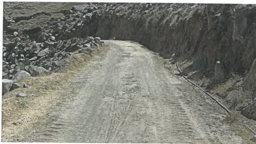
Ilustración 5 Bombeo en la ruta inexistente
