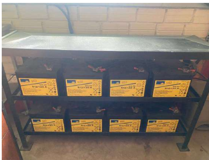
Fig. N° 09 RACK DE BATERIAS A SER REEMPLAZADO
