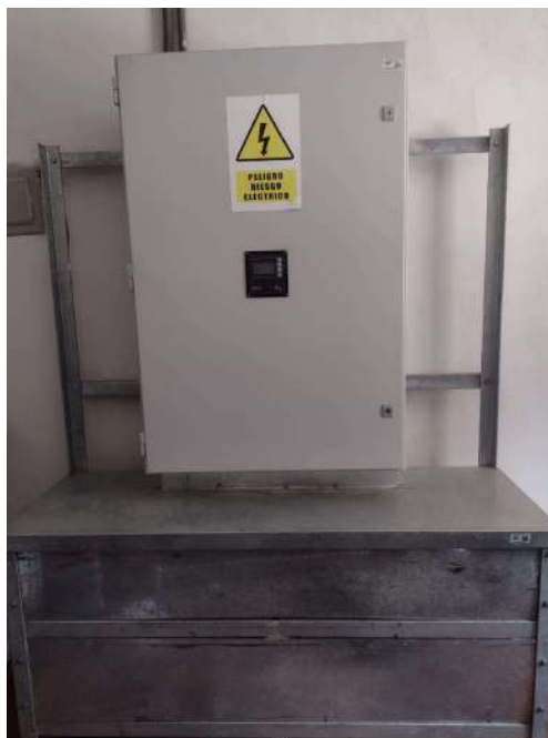
Fig. N° 11 RACK DE BATERIAS
