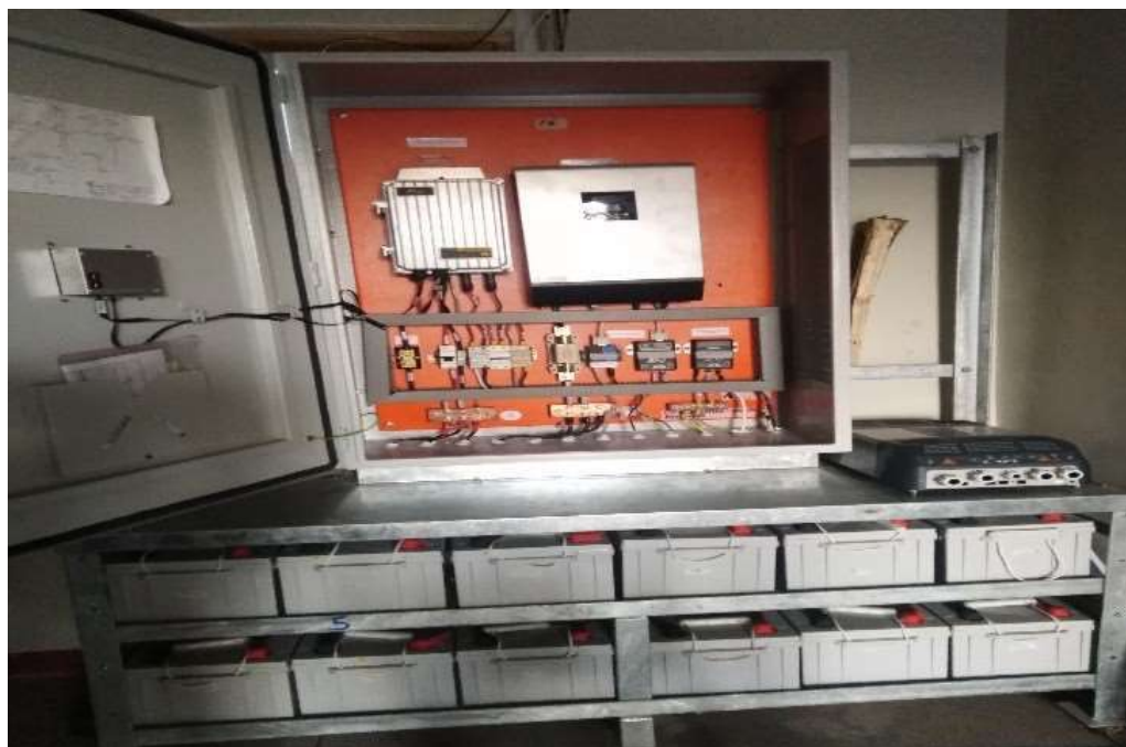
Fig. N° 03 RACK DE BATERIAS
