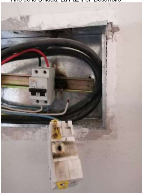
Fig. N° 10 TABLERO DE TRANSFERENCIA A SER REEMPLAZADO
