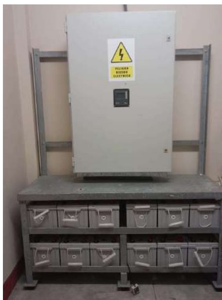
Fig. N° 07 RACK DE BATERIAS
