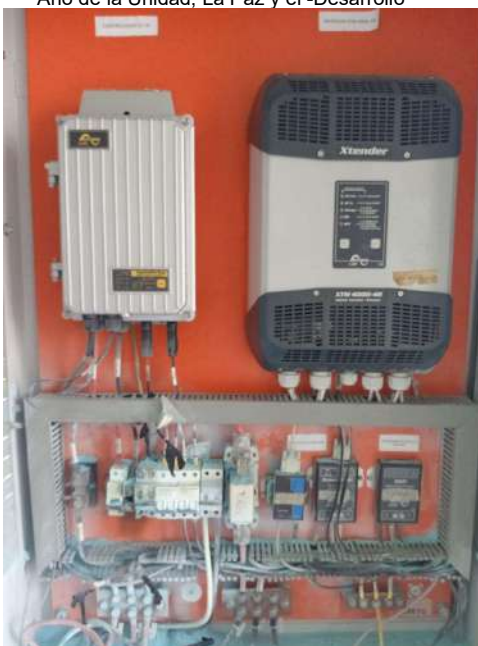
Fig. N° 12 TABLERO DE CONTROL PARA CAMBIO DE EQUIPOS
