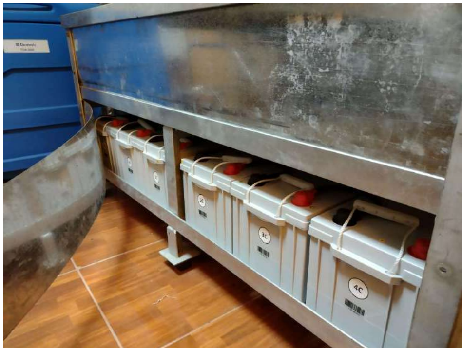
Fig. N° 08 RACK DE BATERIAS
