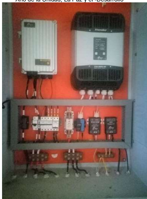
Fig. N° 06 TABLERO DE CONTROL
