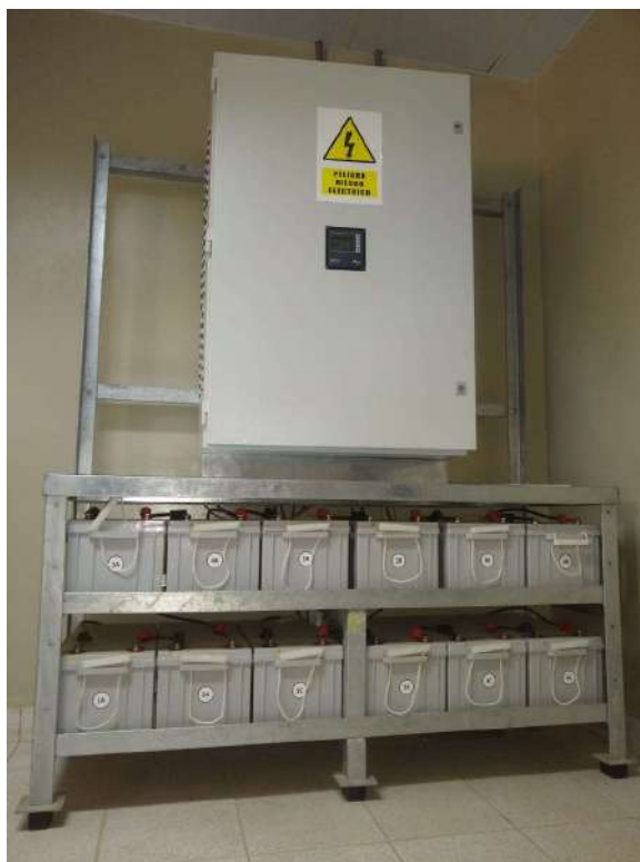
Fig. N° 03 RACK DE BATERIAS
