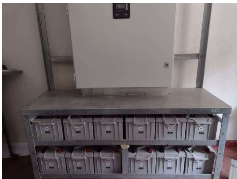
Fig. N° 06 RACK DE BATERIAS
