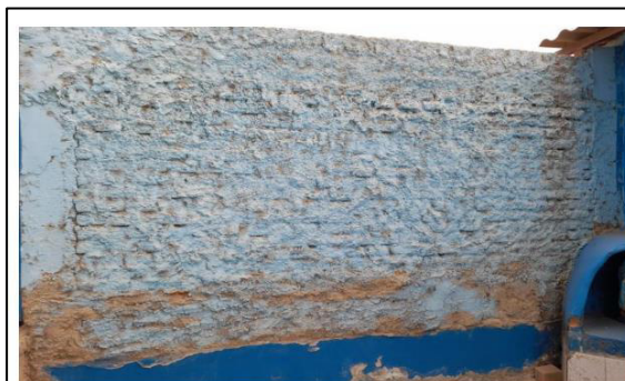
Ilustración 12. Se muestra parte del cerco perimétrico de adobe (material precario)
