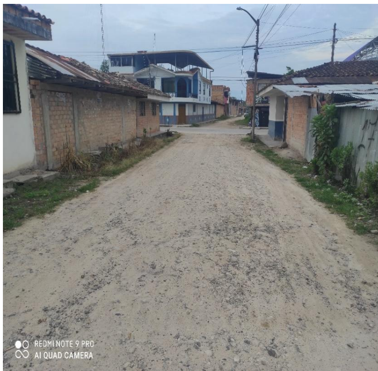
Jr. Ricardo Palma C 06 – En esta imagen también se puede observar la deficiencia de cunetas para el drenaje de aguas pluviales optimas.
