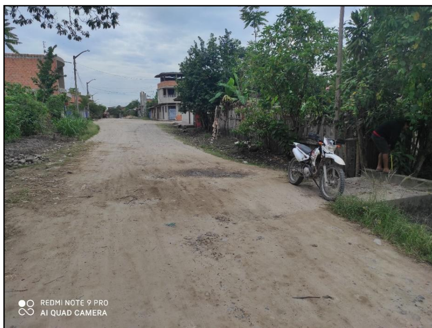
Jr. Bolognesi C 16 – En la siguiente imagen se puede demostrar los problemas de deterioro de las vías por la acumulación de las aguas en la parte de la calzada.
