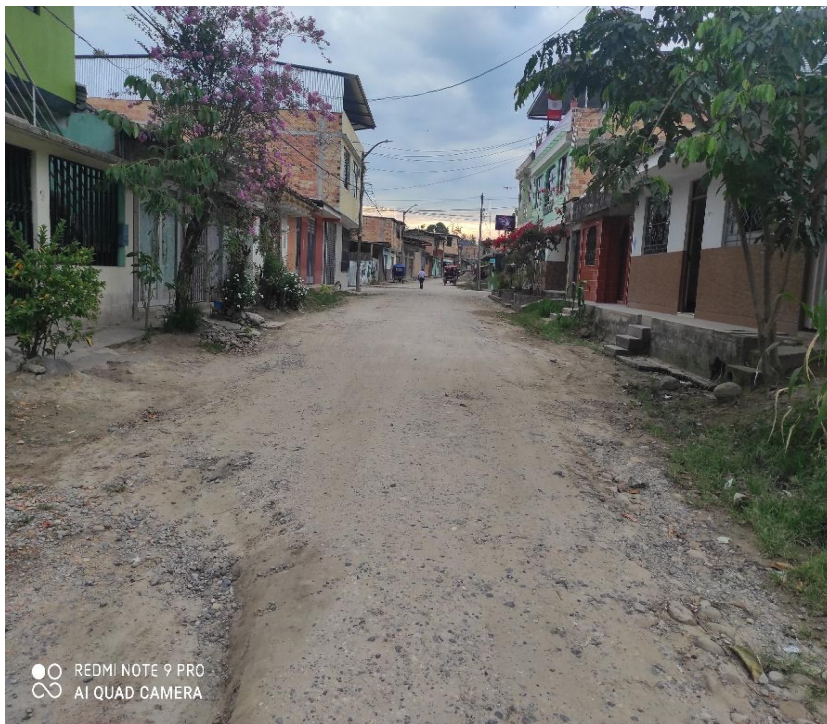
Jr. Ricardo Palma C 07 – Dicha calle no cuenta con un drenaje para las evacuaciones de las aguas de lluvia, y eso permite que se acumulen deteriorando la calzada, provocando intransitabilidad.
