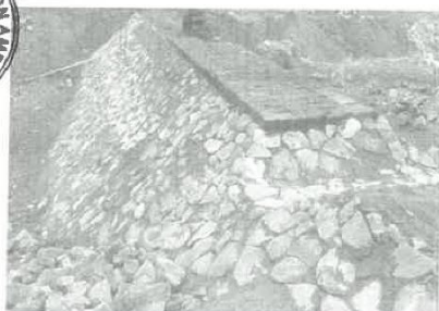
Figura N° 2: Vista de Colocación de Piedra en Talud Aguas Arriba y Abajo
