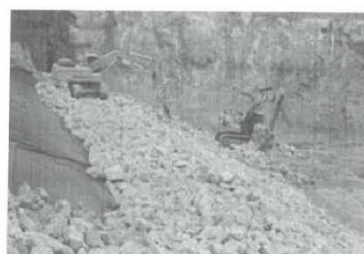
Figura N° 2: Vista de Colocación de Piedra en Talud Aguas Arriba y Abajo
