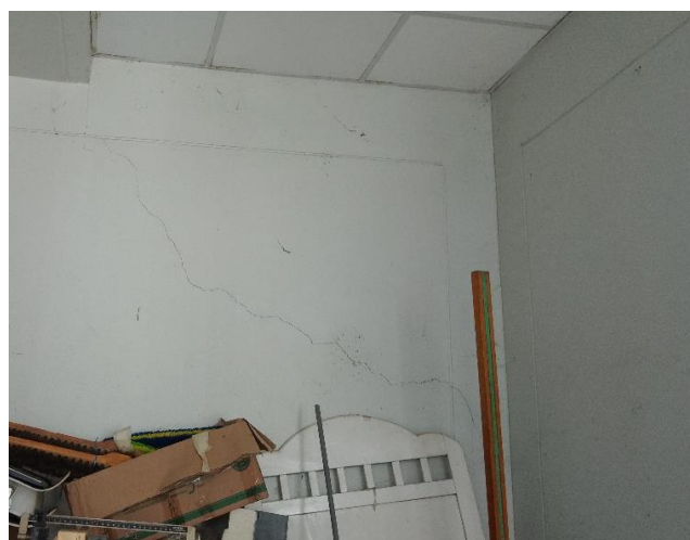
Vista de la fisura, causado por la humedad. Se plantea resane y pintado. Ambiente almacén.
