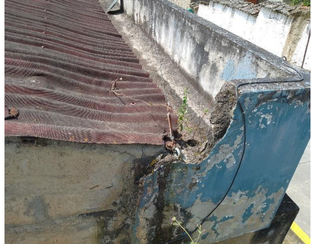
Vista a detalle del concreto desmoronado de la canaleta, se plantea refacción y repintado
