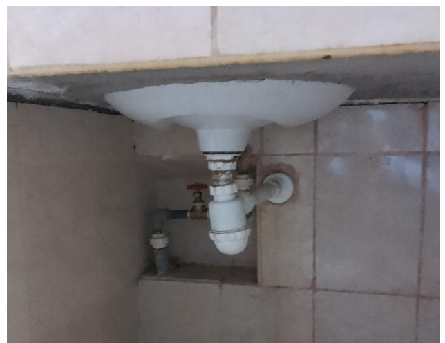
Vista de la trampa de lava mano dañado. Se plantea cambio ambiente sala de parto
