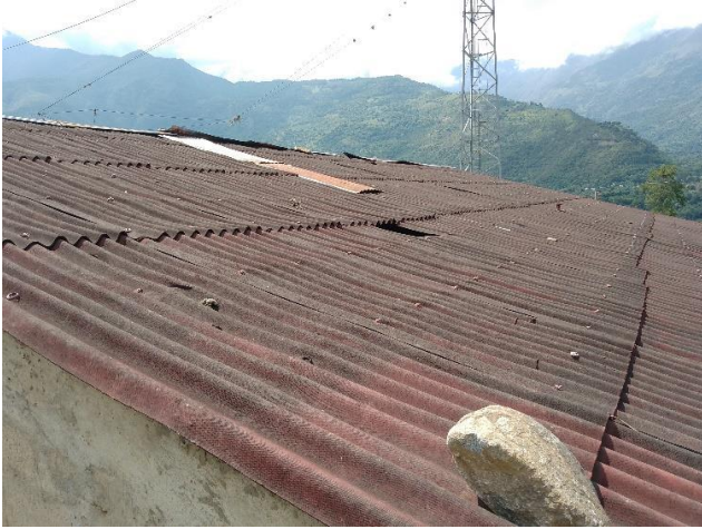
Vista donde se aprecia ondula miento y daño generalizado de la cubierta. Se plantea cambio total
