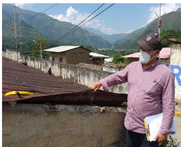
Vista del especialista que demuestra el daño generalizado e irreversible de la cubierta. Se planeta cambio total
