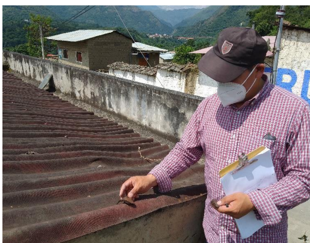
Vista del especialista que demuestra la descomposición del material de cubierta. Se planeta cambio total
