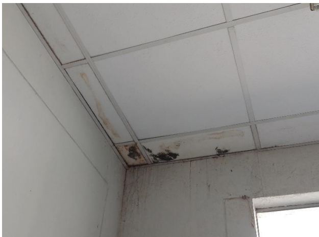
Vista del cielo raso con baldosa, presencia de manchas con moho, causado por la humedad. Se plantea cambio-ambiente
