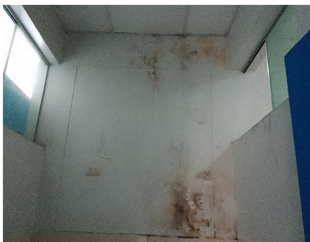
En la vista se aprecia manchas con moho, causado por la humedad. Se plantea repintado. baño de varones
