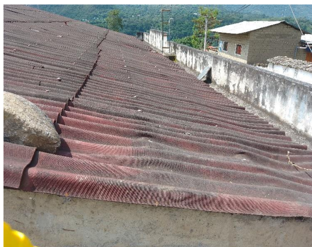
Vista a detalle del material de cubierta con daños generalizados. Se planeta cambio total
