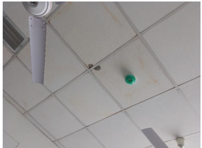
Manchas en el techo de baldosa, ocasionado por goteras. Se plantea cambio de baldosas dañadas. Ambiente cadena de frio.
