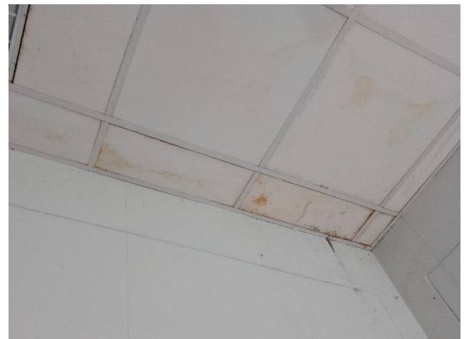
Vistas del cielo raso con baldosa, presencia de manchas, causado por la humedad. Se plantea cambio-ambiente consultorio
