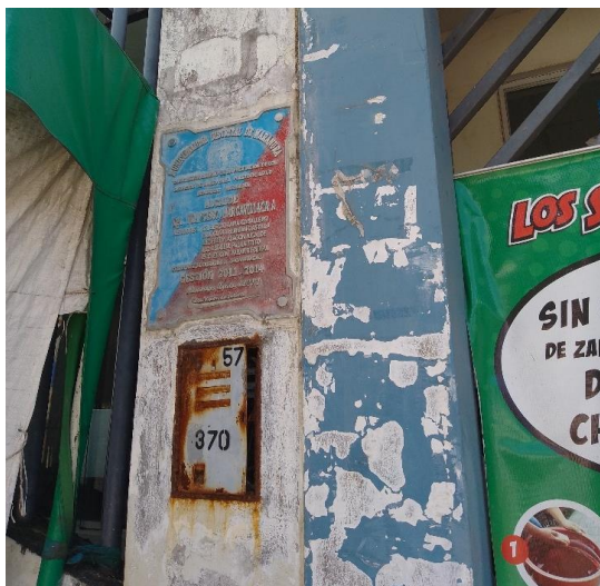
Vistas del proceso de exfoliación de la pintura, columna de la puerta principal. Se plantea resane y repintado.
