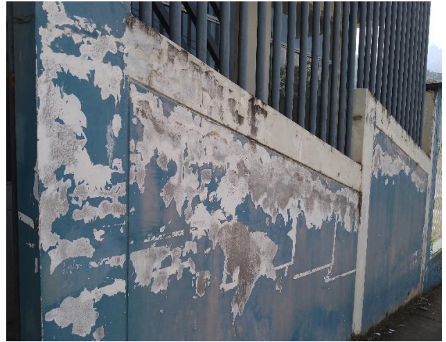
Vista del cerco perimétrico donde se aprecia exfoliación de las capas de pintura. Se plantea repintado.
