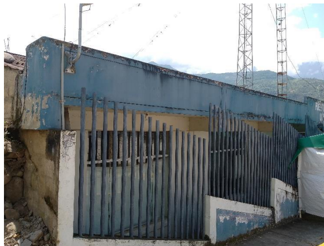
Vista donde se aprecia presencia de manchas con moho en la canaleta de concreto. Se plantea repintado.
