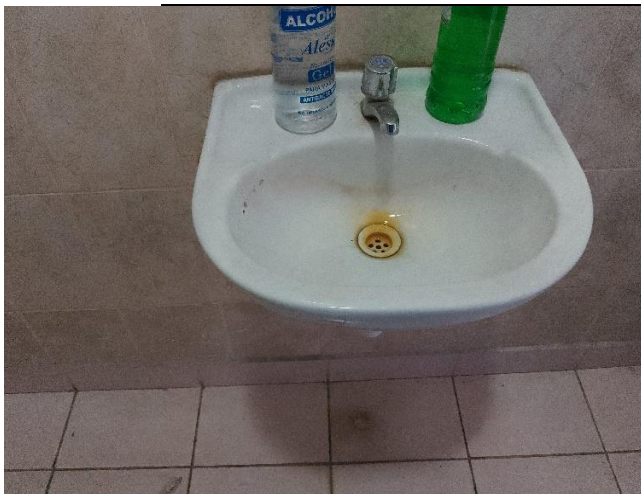
Vista del grifo de lava mano dañado, se plantea cambio ambiente baño de varones
