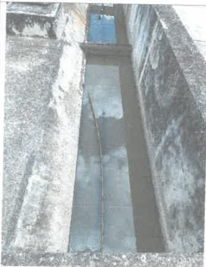
Foto 011.- Falla de la guía de distribución RAFA 2
