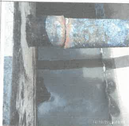
Foto 010.- Tubería dañada RAFA 01
