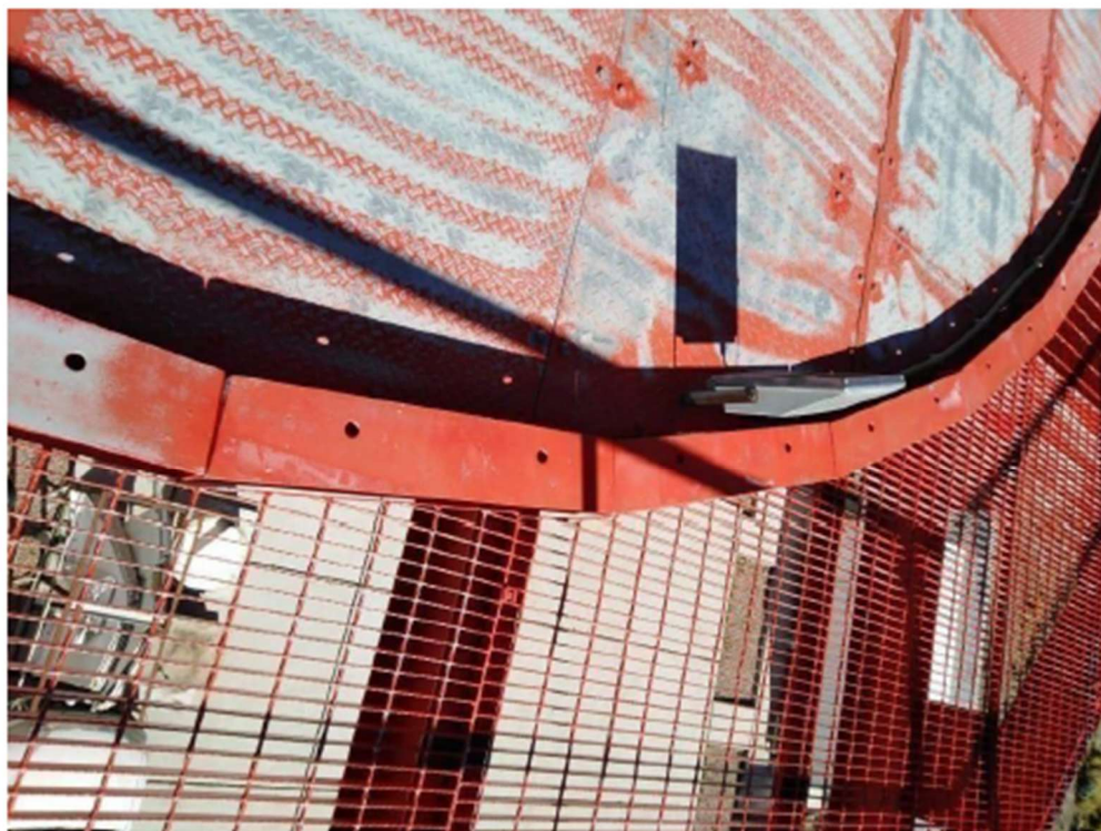
FIGURA 07 | Base de plataforma de la Antena Radar donde empalma Radomo
