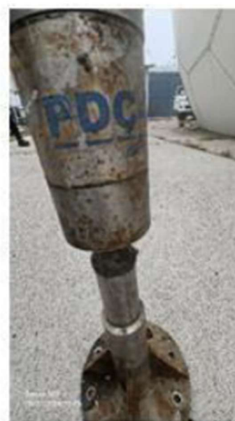
Figura 11 | Pararrayos existente
