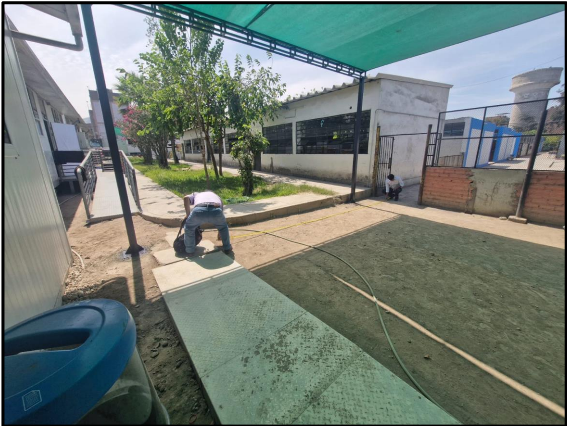
Fotografía 7. Verificación de los límites del área a intervenir, acondicionamiento de losa de concreto e instalación de malla raschel (Patio 03 - inicial).
