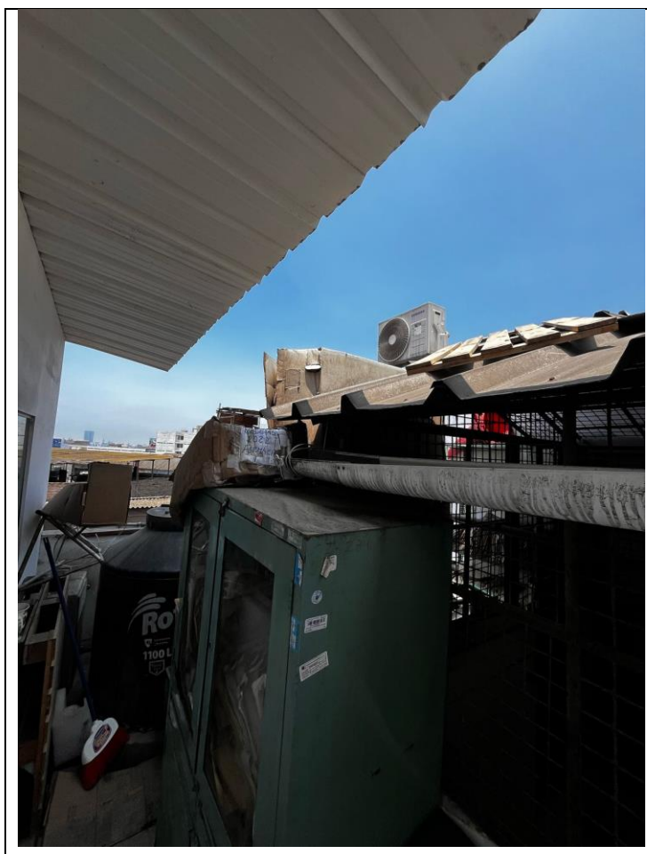
Foto 8. Se observa techos de Aluzinc deteriorados y tanque elevado sin cobertura metálica
