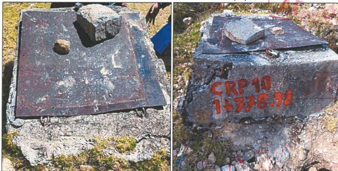
FIGURA N° 38: Estado situacional actual de la cámara rompe presión N°10 T-VI
