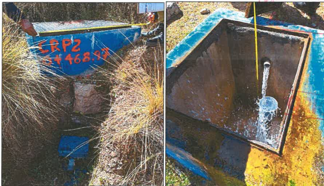
FIGURA N° 30: Estado situacional actual de la cámara rompe presión N°2 T-VI
