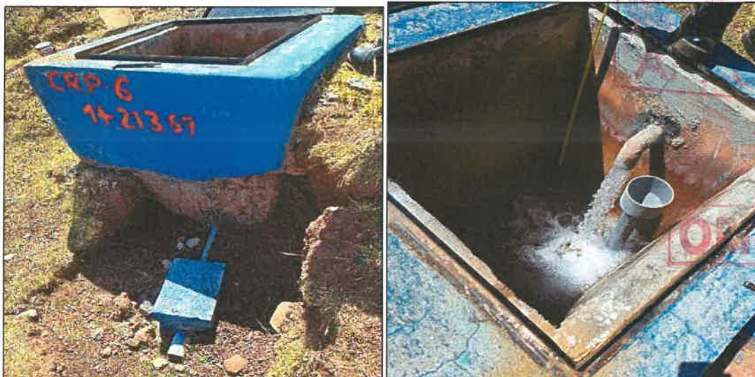
FIGURA N° 34: Estado situacional actual de la cámara rompe presión N°6 T-VI
