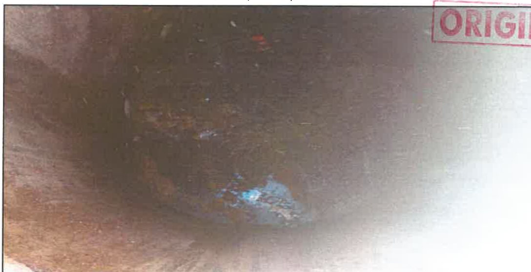
FIGURA N° 48: En la foto se puede apreciar buzones colmatados.
