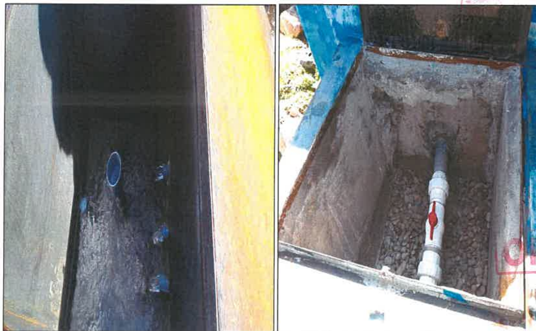
FIGURA N° 26: Cámara Húmeda y cámara seca de la Captación Existente Paqchiñahuin III
