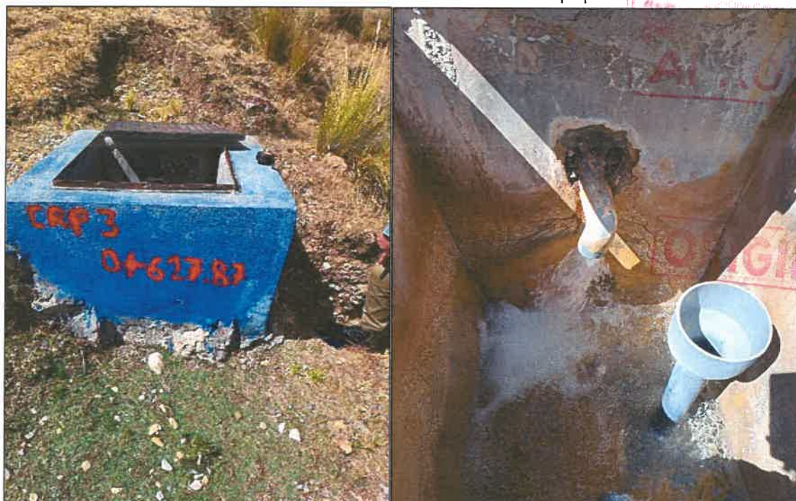
FIGURA N° 31: Estado situacional actual de la cámara rompe presión N°3 T-VI
