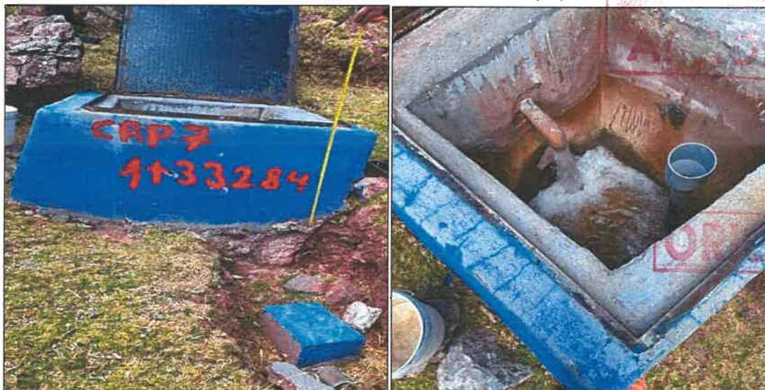
FIGURA N° 35: Estado situacional actual de la cámara rompe presión N°7 T-VI
