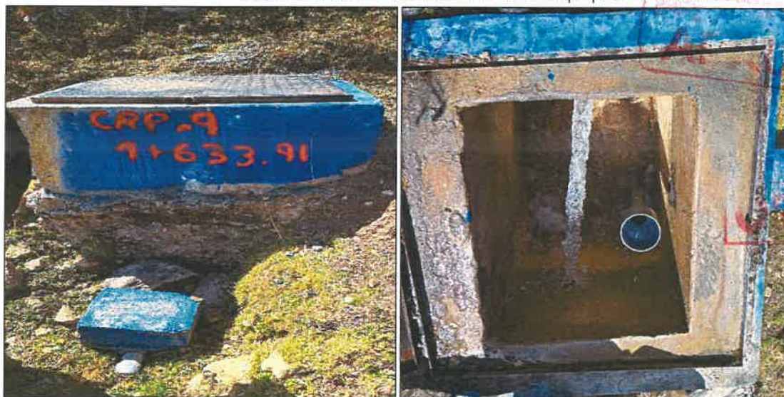
FIGURA N° 37: Estado situacional actual de la cámara rompe presión N°9 T-VI
