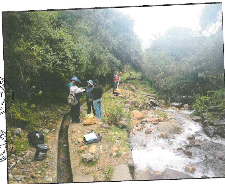
Figura 02.- Estado actual del canal, deteriorado y presencia de fisuras laterales. Produciendo filtraciones y pérdida de caudal.
