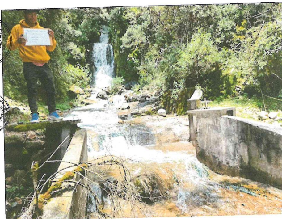
Figura 01.- Estado actual de la captación, deficiente funcionamiento por deterioro del río sobre la estructura.
