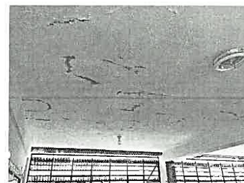
Módulo 3: Vista interior de la I.E.P. N° 16002. Existe filtraciones en el techo cuando llueve
