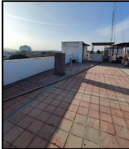
Fotografía: imagen del ladrillo pastelero existente debajo del manto asfáltico.
