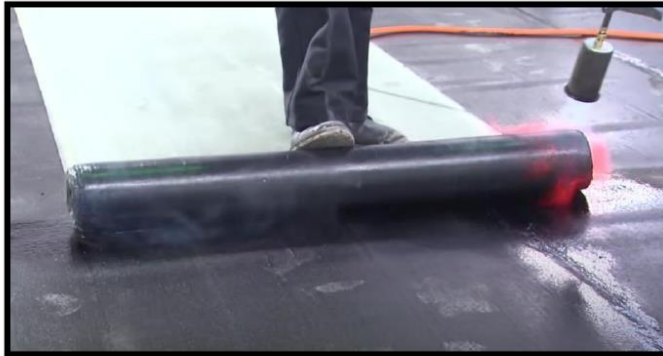
Imagen Referencial de la instalación del Manto Asfáltico aplicando Termo sellado utilizando soplete a gas. Las medidas de los traslapes por ningún motivo serán menores a las indicadas en la ficha técnica del producto
