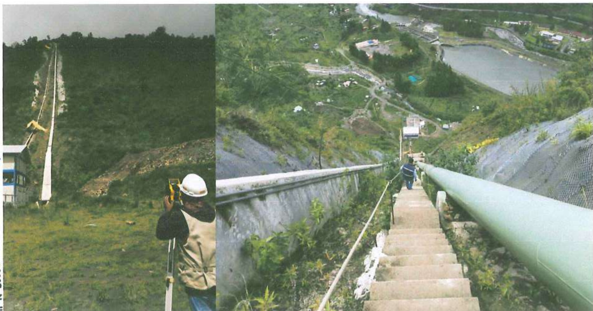
Figura 6. Tramo de la tubería forzada
