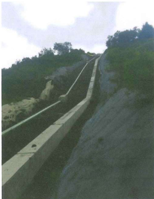
Figura 5. Vista de la canal rápida de demasías donde se observa que este alojado en una zanja de excavación.
