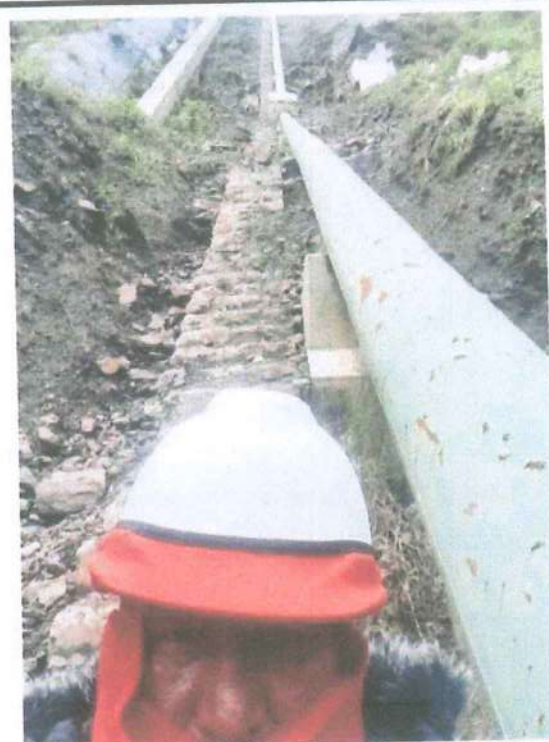
Gráfico N°:06 Se pudo visualizar la erosión de rocas, arenas, arcillas Que dificultaban el paso a la zona de estudio, y las gradas totalmente dañadas.
