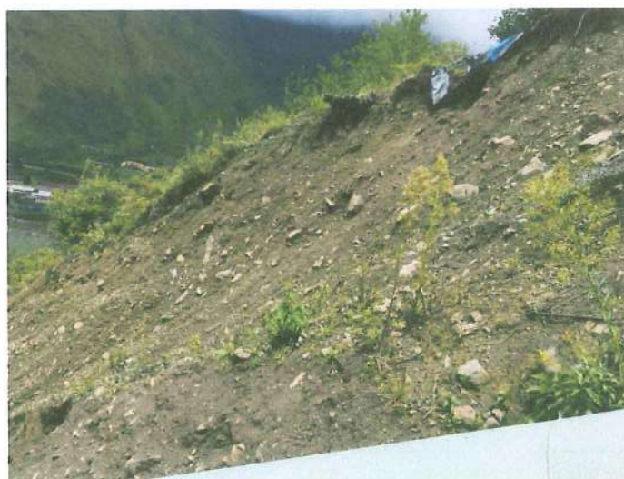
Foto 2: Inicio del deslizamiento talud derecho progresiva 0+008
