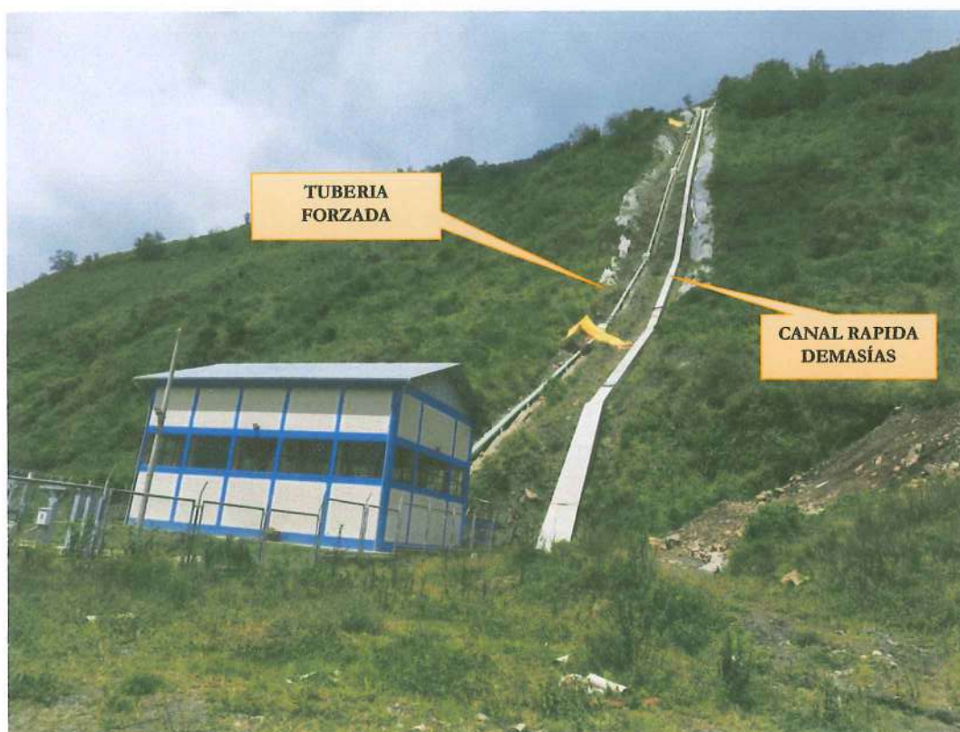
Foto 5: Vista de la Tubería Forzada y canal de rápida demasías
