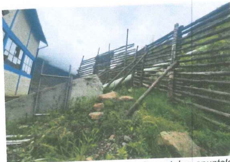
Gráfico N°:02 Protección con barricadas de puntales, apuntaladas ante un eventual deslizamiento de
