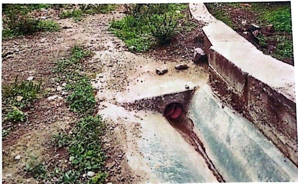
Fotografía N°04: Drenaje pluvial, al costado del baden de la Vía Nacional PE-12B.
