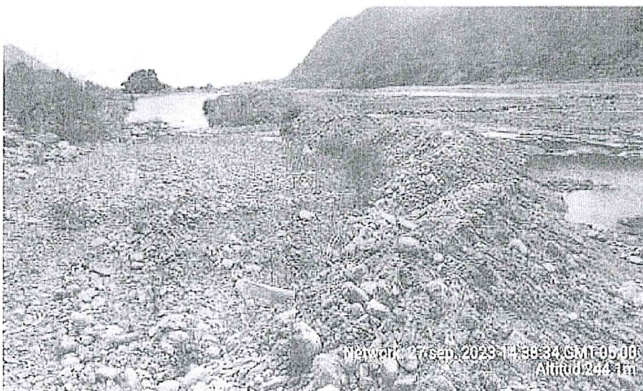
Se aprecia que ante un incremento del Caudal del Río La Leche el bordo de 1.00 ml de altura no brindara la protección adecuada al sector.
