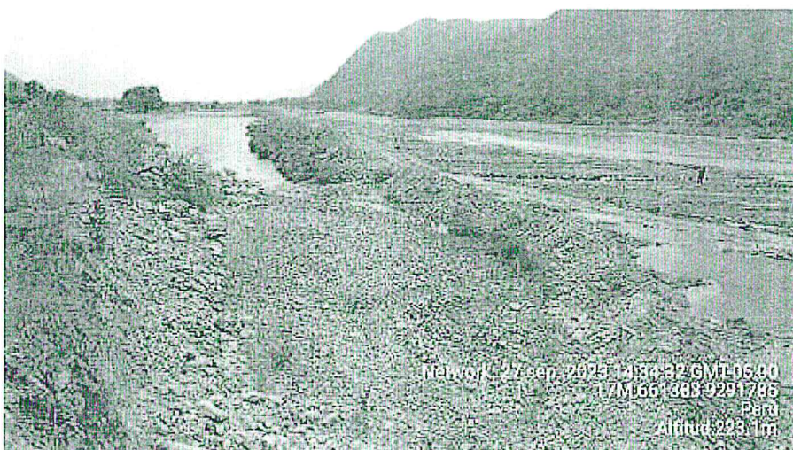
Vista de la margen izquierda del Río La Lecha, donde se tiene un tramo con un arrimado de material de río de aproximadamente 1.00 ml, e cual no garantiza la suficiente protección.
