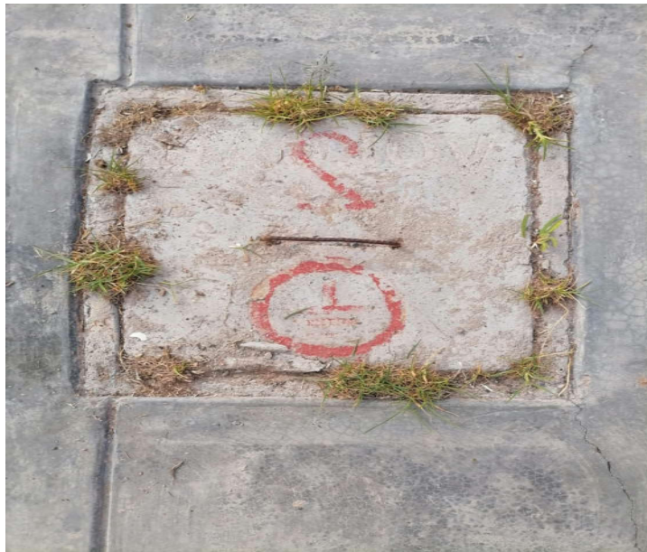
Fig. N° 10 POZO PARA LIMPIEZA EXTERNA Y CAMBIO DE CONECTOR TIPO AB
