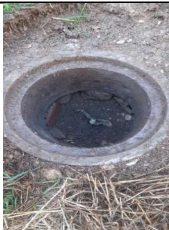
Fig. N° 30 POZOS PARA CAMBIO DE CONECTOR Y LIMPIEZA
