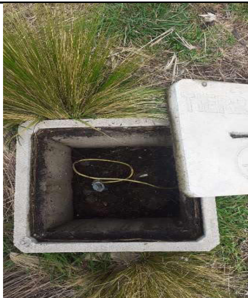
Fig. N° 21 UBICADO EN LA PARTE POSTERIOR, COSTADO DERECHO, PRESENTA CAJA DE CONCENTRO CON TAPA, SIN PINTAR Y PRESENCIA DE OXIDOS. (pozo a intervenir).
