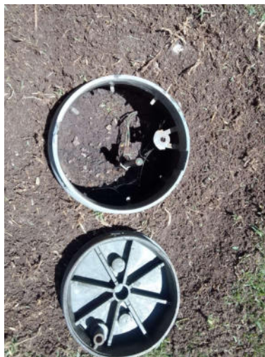
Fig. N° 15 UBICADO EN LA PARTE POSTERIOR CENTRAL DEL TAMBO CON TAPA DE PLASTICO Y PRESENTA CABLE Y CONECTOR DETERIORAD (pozo a intervenir).
