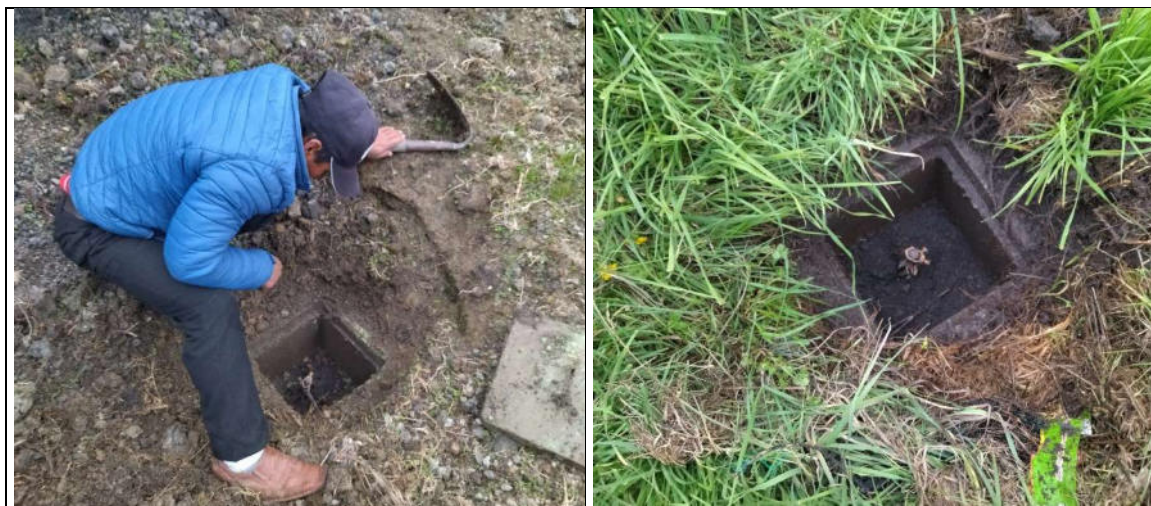
Fig. N° 17 POZOS UBICADOS ALREDEDOR DEL TAMBO, PARA EL CAMBIO DE CONECTOR Y TAPA
