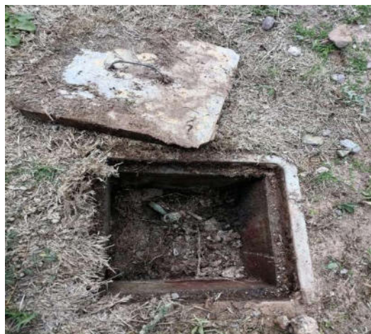
Fig. N° 09 UBICADO EN LA PARTE POSTERIOR IZQUIERDO, PRESENTA CAJA DE CONCRETO SIN PINTAR (pozo a intervenir)
