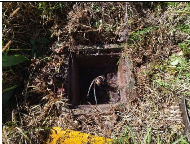
Fig. N° 16 UBICADO EN LA PARTE LATERAL IZQUIERDO, POSTERIOR, DE FORMA CUADRADA MATERIAL DE CEMENTO. DETERIORADA (pozo a intervenir).
