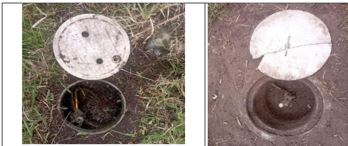
Fig. N° 32 POZOS PARA CAMBIO DE CONECTOR Y LIMPIEZA.
