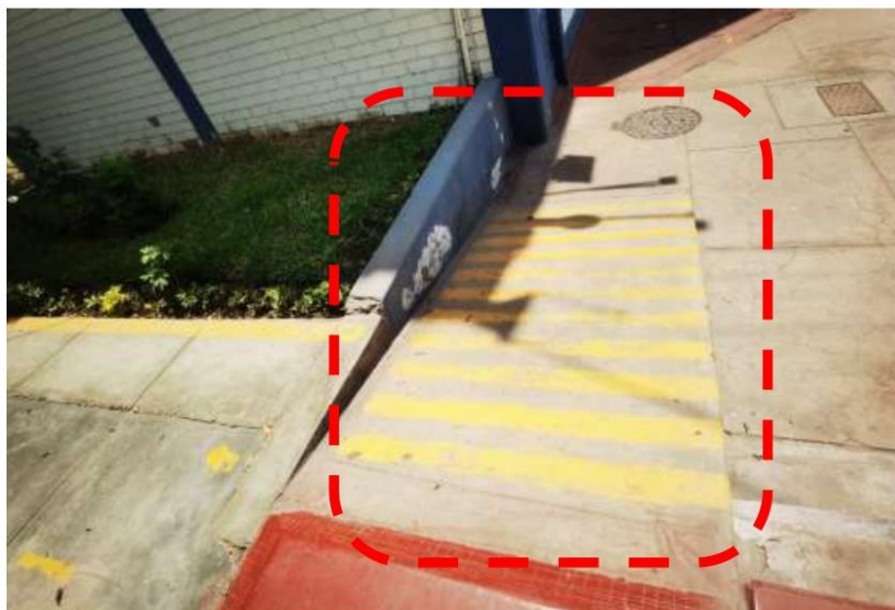
Fotografía N° 08.- Vista de Rampa N°08 cuenta con una rampa que no cumple con la normativa vigente, en cuanto a barandas pendiente y dimensiones reglamentarias.
