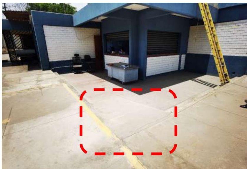
Fotografía N° 04.-, Vista de Rampa N°04 cuenta con una rampa que no cumple con la normativa vigente, en cuanto a barandas pendiente y dimensiones reglamentarias.
