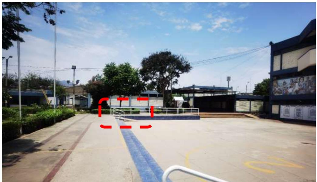
Fotografía N° 06.- Vista de Rampa N°06 cuenta con una rampa que no cumple con la normativa cuanto a barandas pendiente y dimensiones reglamentarias..
