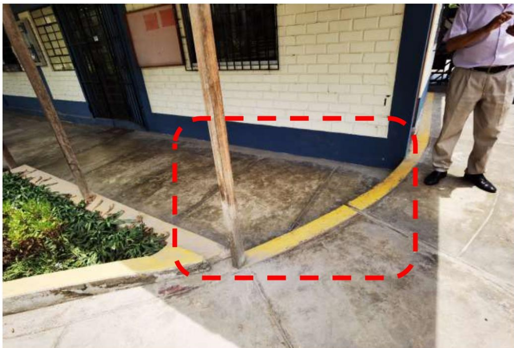
Fotografía N° 02.- Vista de Rampa N°02 cuenta con un desnivel y no existe rampa para el desnivel, se propone una rampa de 12%.
