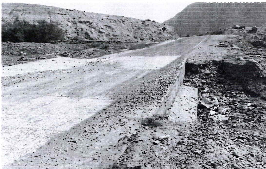
FOTO N° 08: KM 9+795 BADÉN DE CONCRETO SEDIMENTADO REQUIERE LIMPIEZA.
