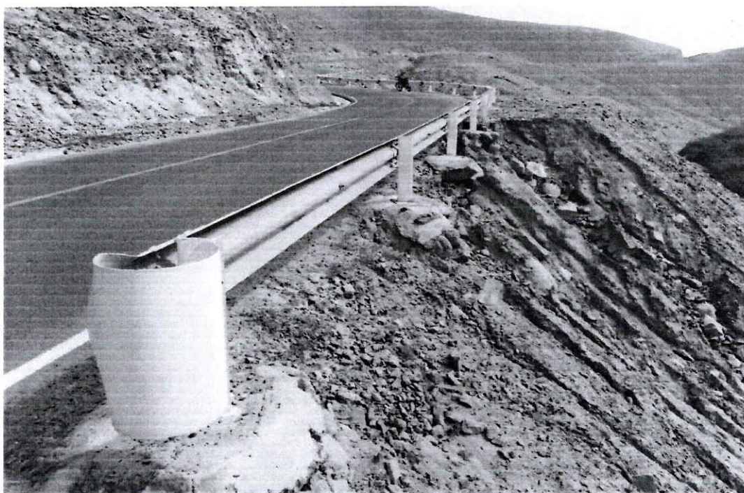
FOTO N° 06: KM 9+480 LADO IZQUIERDO REQUIERE REPARACIÓN MURO SECO DE PIEDRA PARA QUE NO COLAPSE LA CALZADA.
