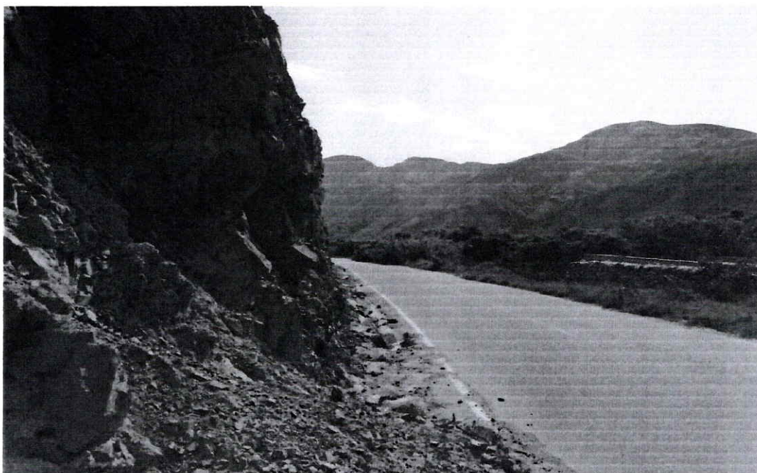
FOTO N° 13: 12+320 REQUIERE EFECTUAR TRABAJOS ELIMINACION DE DERRUMBES LADO DERECHO DE LA VIA.
