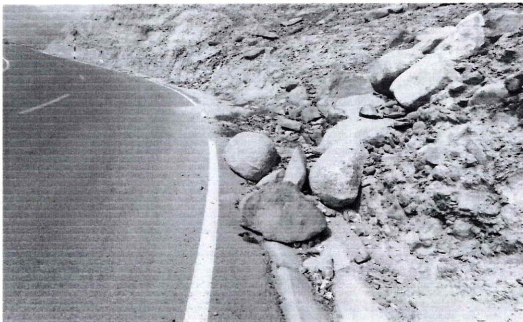
FOTO N° 10: KM 11+340 SE NECESITA ELIMINACIÓN DE ROCAS POR DERRUMBES DEL TALUD SUPERIOR.
