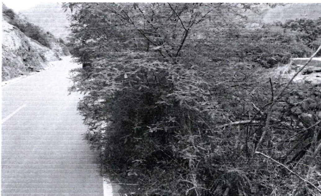
FOTO N° 16: KM. 14+735 LA VEGETACIÓN EXCESIVA SOBRE LA CALZADA SE DEBERÁ REALIZAR TRABAJOS DE ROCE Y LIMPIEZA.
