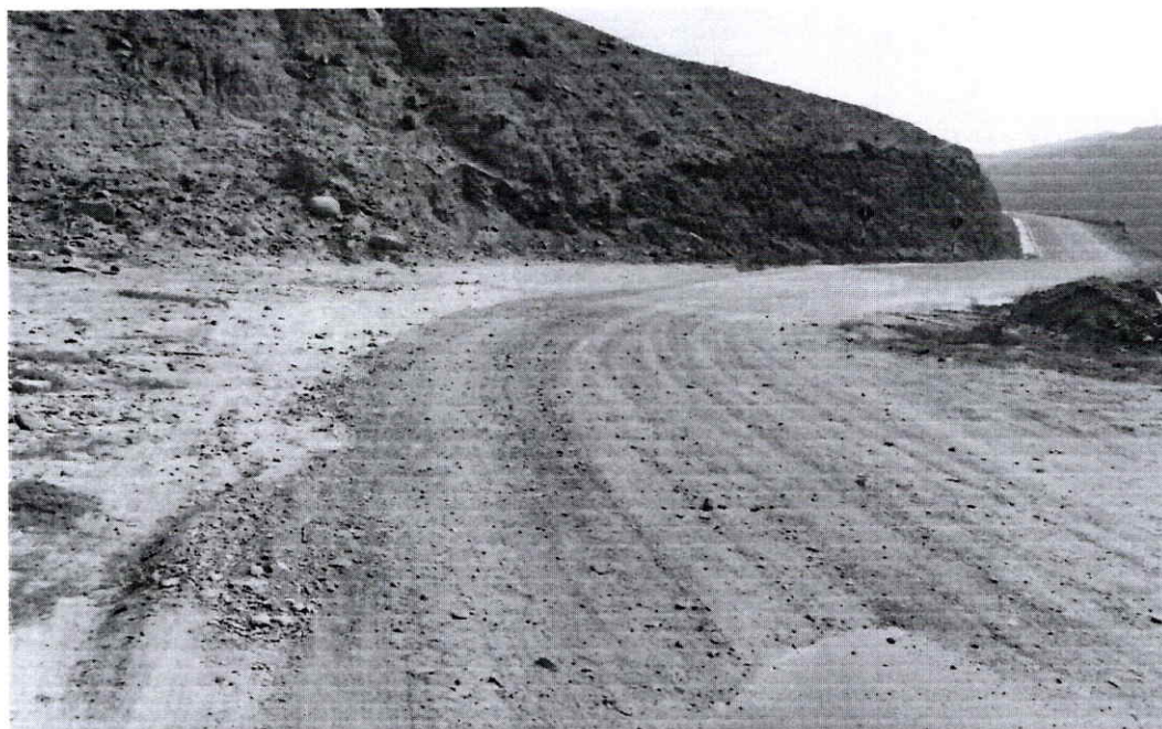
FOTO N° 05: BADÉN KM 8+285 SE APRECIA BADEN COLMATADO DE SEDIMENTOS REQUIERE REALIZAR TRABAJOS DE ELIMINACION DE SEDIMENTOS.
