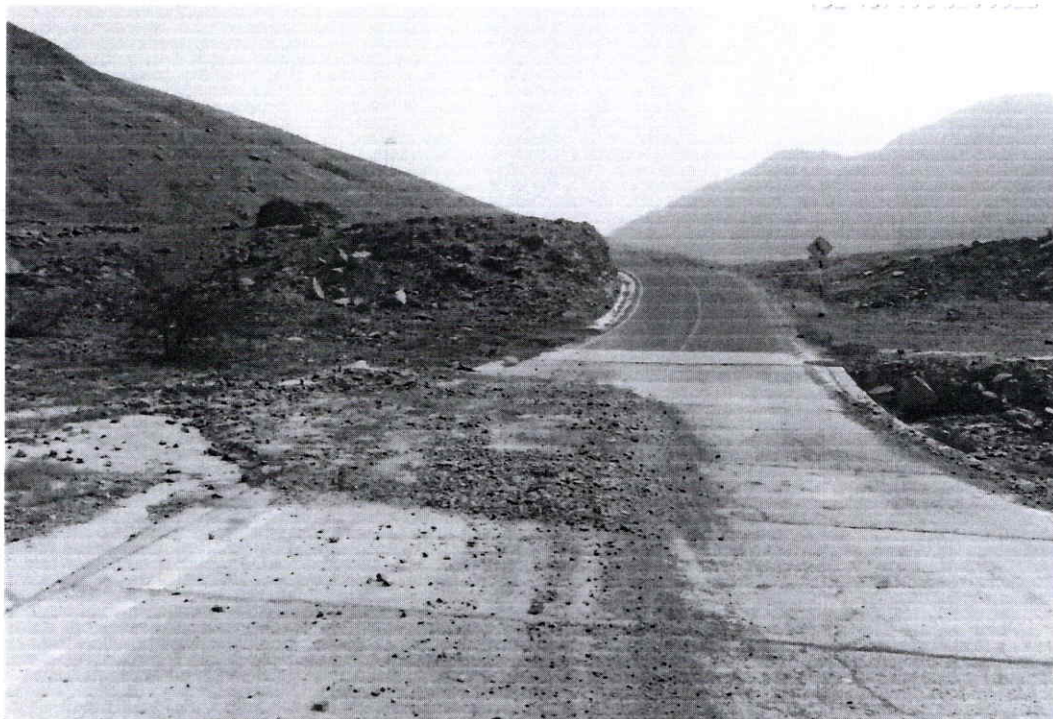
FOTO N° 11: KM 11+ 477 ELIMINACION DE SEDIMENTOS Y REALIZAR MURO SECO LADO IZQUIERDO BADÉN.
