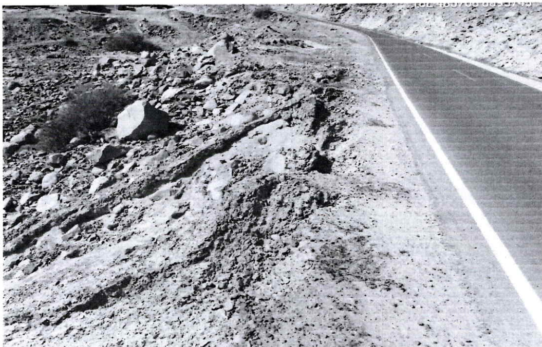
FOTO N° 07: KM 9+570 EFECTUAR TRABAJOS DE REPARACIÓN MURO SECO LADO IZQUIERDO DE TALUD INFERIOR.
