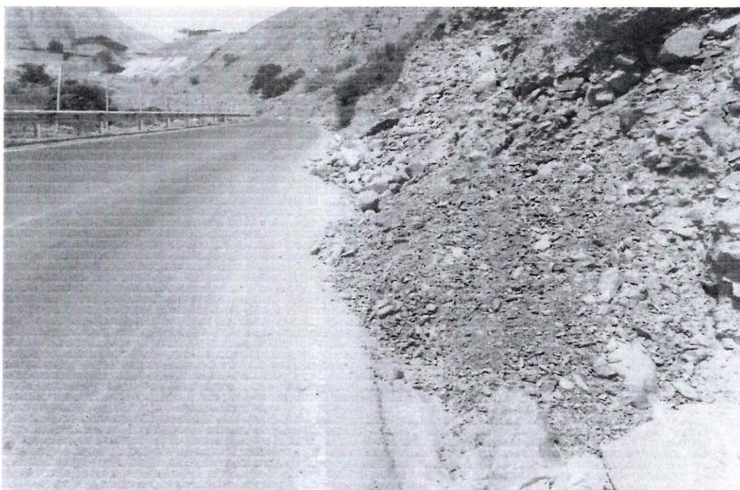
FOTO N° 14: KM 13 +420 SE NECESITA ELIMINACIÓN DE DERRUMBES LADO DERECHO DE LA VIA.
