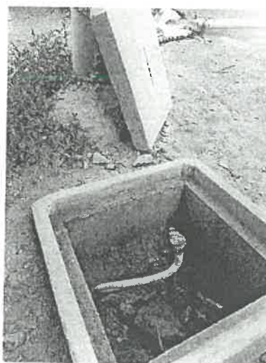
Puesta a tierra requiere mantenimiento
