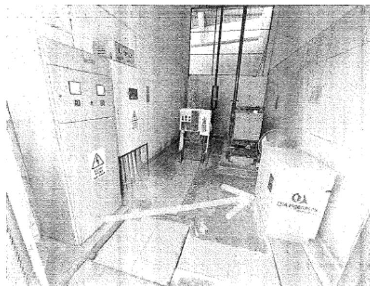
Foto N°2 : Transformador de 100KVA que será retirado y reemplazado por el de 250KVA.
