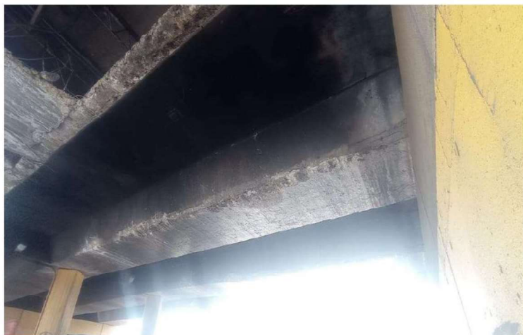
Figura 04.- Vista inferior del estado de la viga cajón, se evidencia desprendimiento del concreto de la cara inferior.
