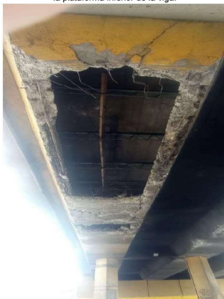
Figura 03.- Vista inferior del estado de la viga cajón, se evidencia desprendimiento del tablero inferior de la viga cajón.
