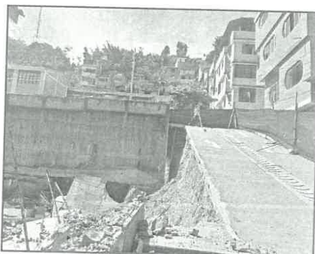
Vista Frontal de la calle Jr. José Olaya, donde se observa el desplome del muro de contención
