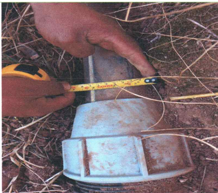
Fotografía N°09: Reducción de manguera 4" a 3"
