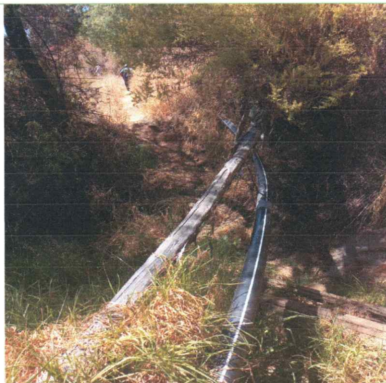
Fotografía N°06: Manguera Hdpe en quebrada
