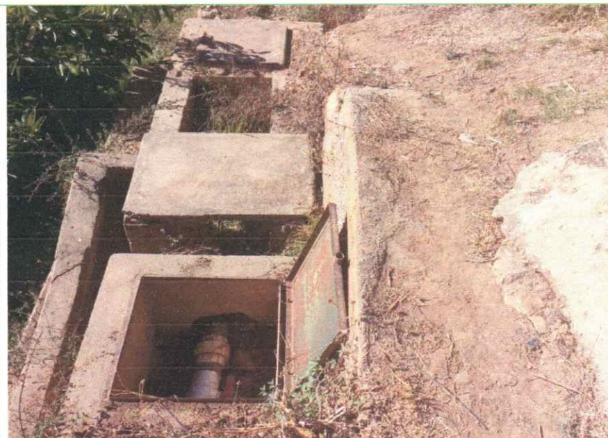
Fotografía N°04: Cajas de control con tapas sanitarias
