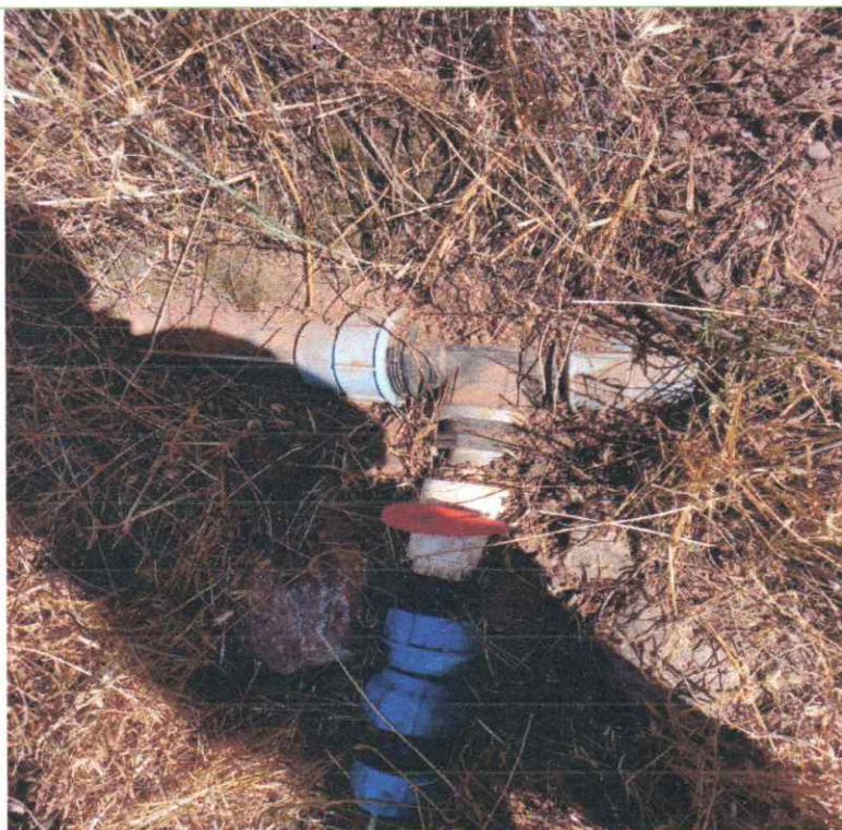
Fotografía N°08: Válvula PVC que cumple la función de Toma parcelaria
