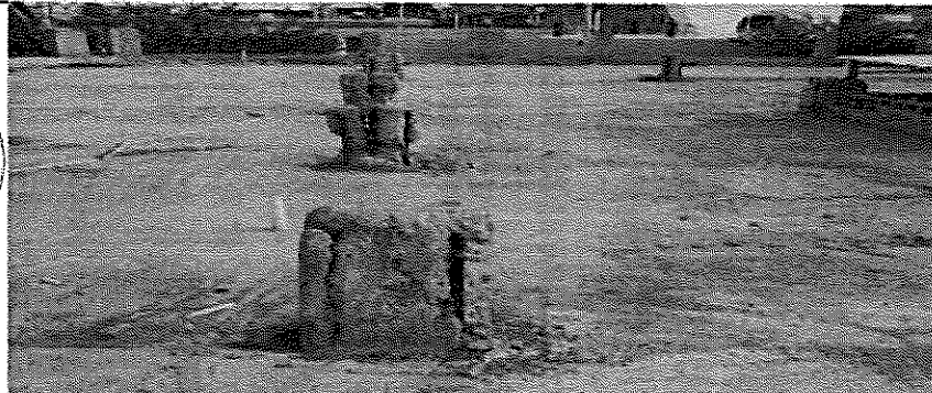
PEDESTALES DE CONCRETO SOBRE LOSA CON ACEROS CORROÍDOS
