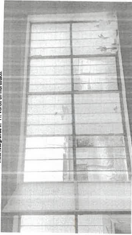
Vista fotográfica n.º 11: vidrios en mal estado.
