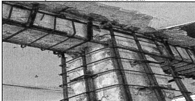
Figura n° 22: Reforzamiento de columnas mediante "Encamisado"
