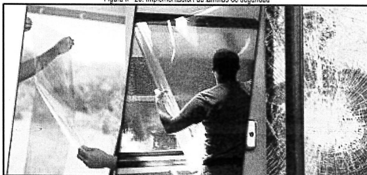
Figura n° 26: Implementación de láminas de seguridad
