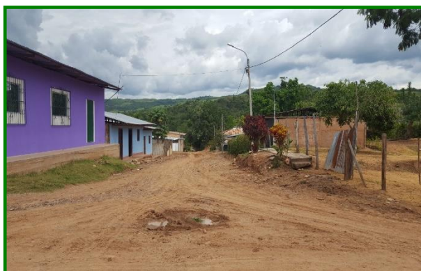
Jr. La Libertad C-2, mal estado de calzada, cunetas inexistentes.
