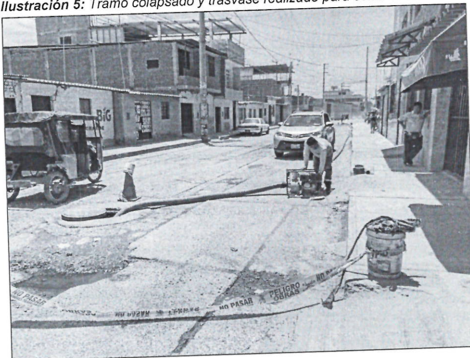
Ilustración 5: Tramo colapsado y trasvase realizado para evitar afloramientos.
