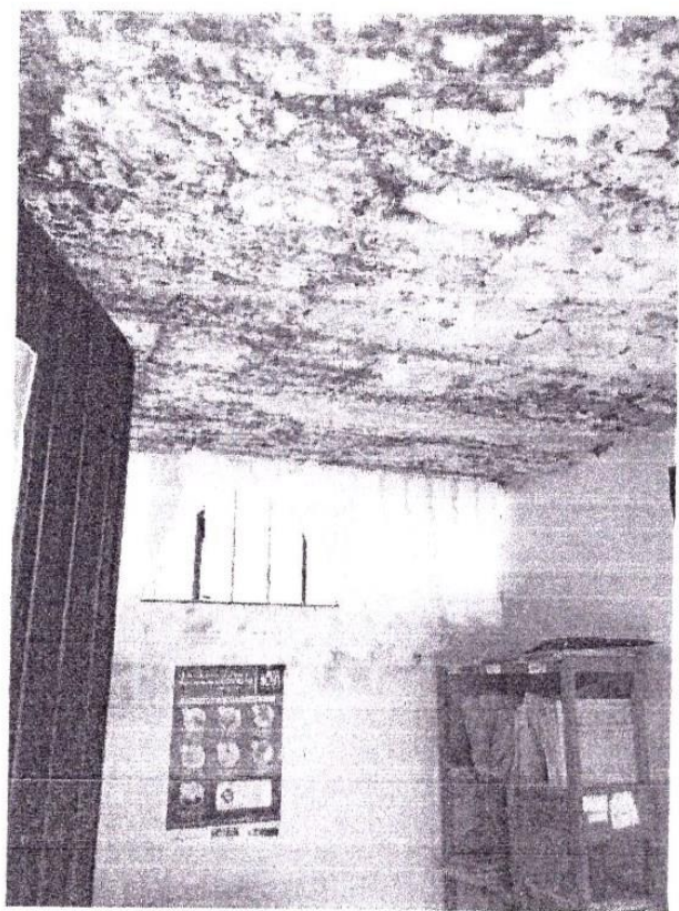
FOTO N°2: LOSA ALIGERADA DEL CONSULTORIO DE OBSTETRICIA DEL PUESTO DE SALUD QUERQUE CON FILTRACION DE AGUA EN EPOCA DE LLUVIAS
