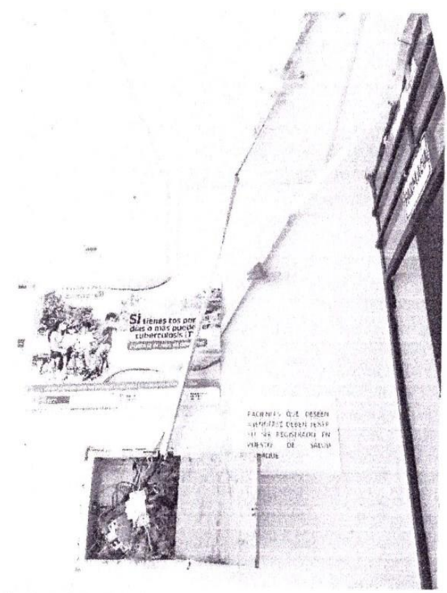
FOTO N°3: REDES ELECTRICAS SIN MANTENIMIENTO, CAJA DE LLAVES EN MAL ESTADO, CABLES SIN CANALIZAR.
