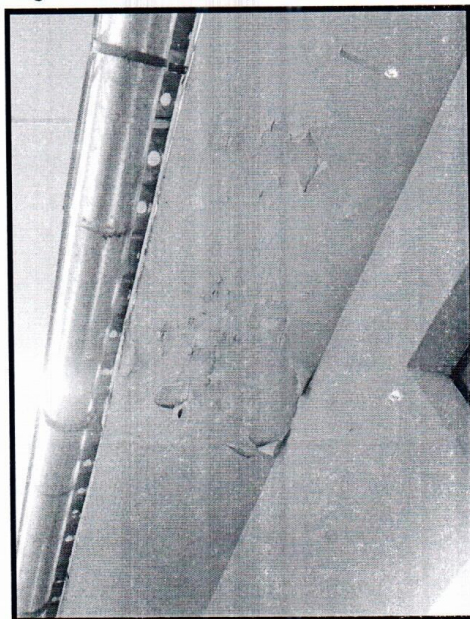
Imagen N.º 6: Alero con desprendimiento de pintura
