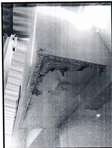
Imagen N.° 2: Alero con desprendimiento
