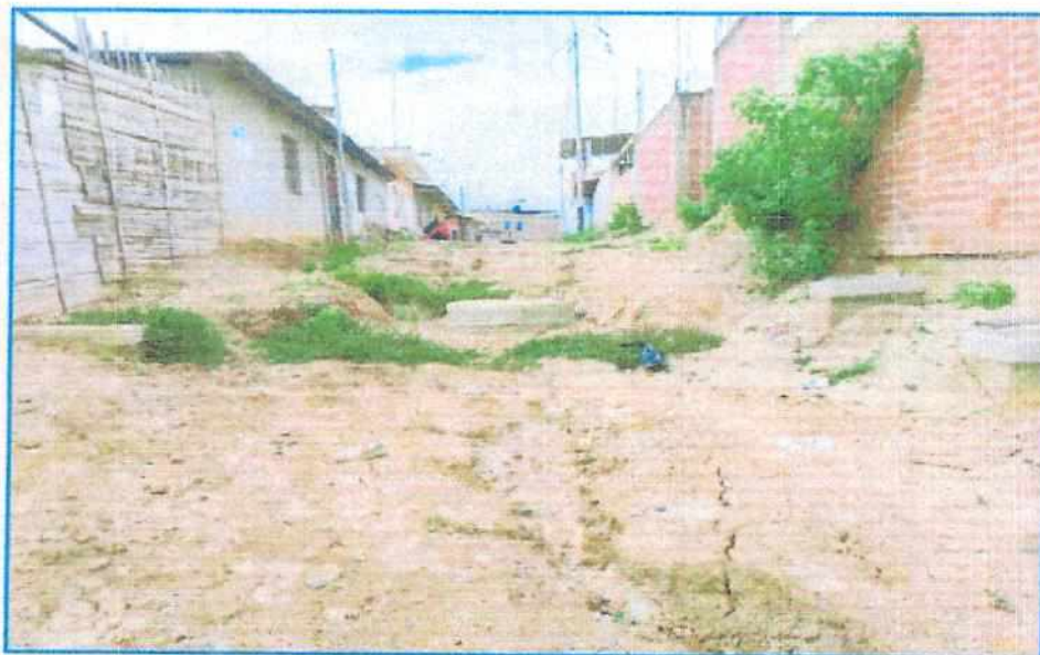
IMAGEN N° 02: CALLE DETERIORADA POR LAS CONSTANTES PRECIPITACIONES PLUVIALES QUE SE VIENEN PRESENTANDO.
