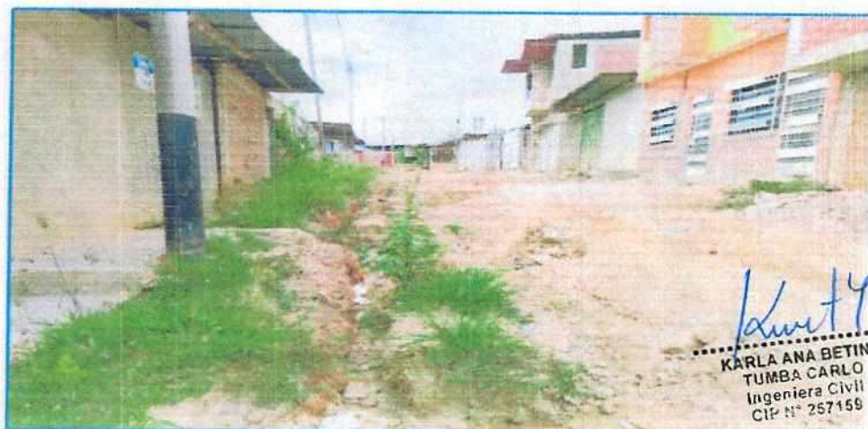
IMAGEN N° 03: EVIDENCIA DE TRAMO CRITICO DE LA CALLE ERIGIONADA, DESTRUIDA POR LAS INTENSAS Y CONSTANTES LLUVIAS
