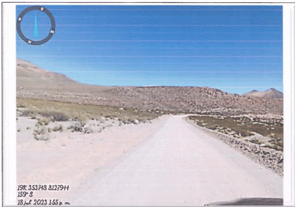
FOTO N° 32: Vista de Plataforma de Rodadura con desgaste por erosion.
