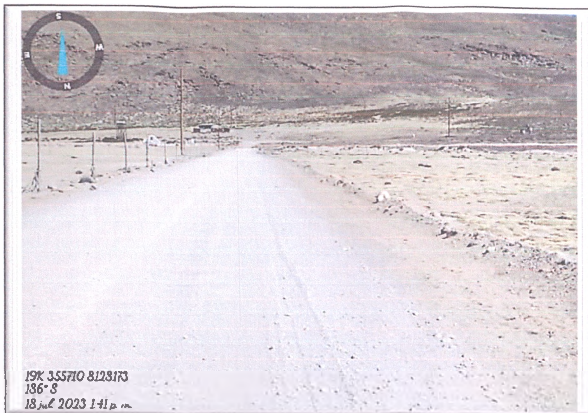
FOTO N° 20: Plataforma de rodadura con desgaste por erosión y ahuellamientos.
