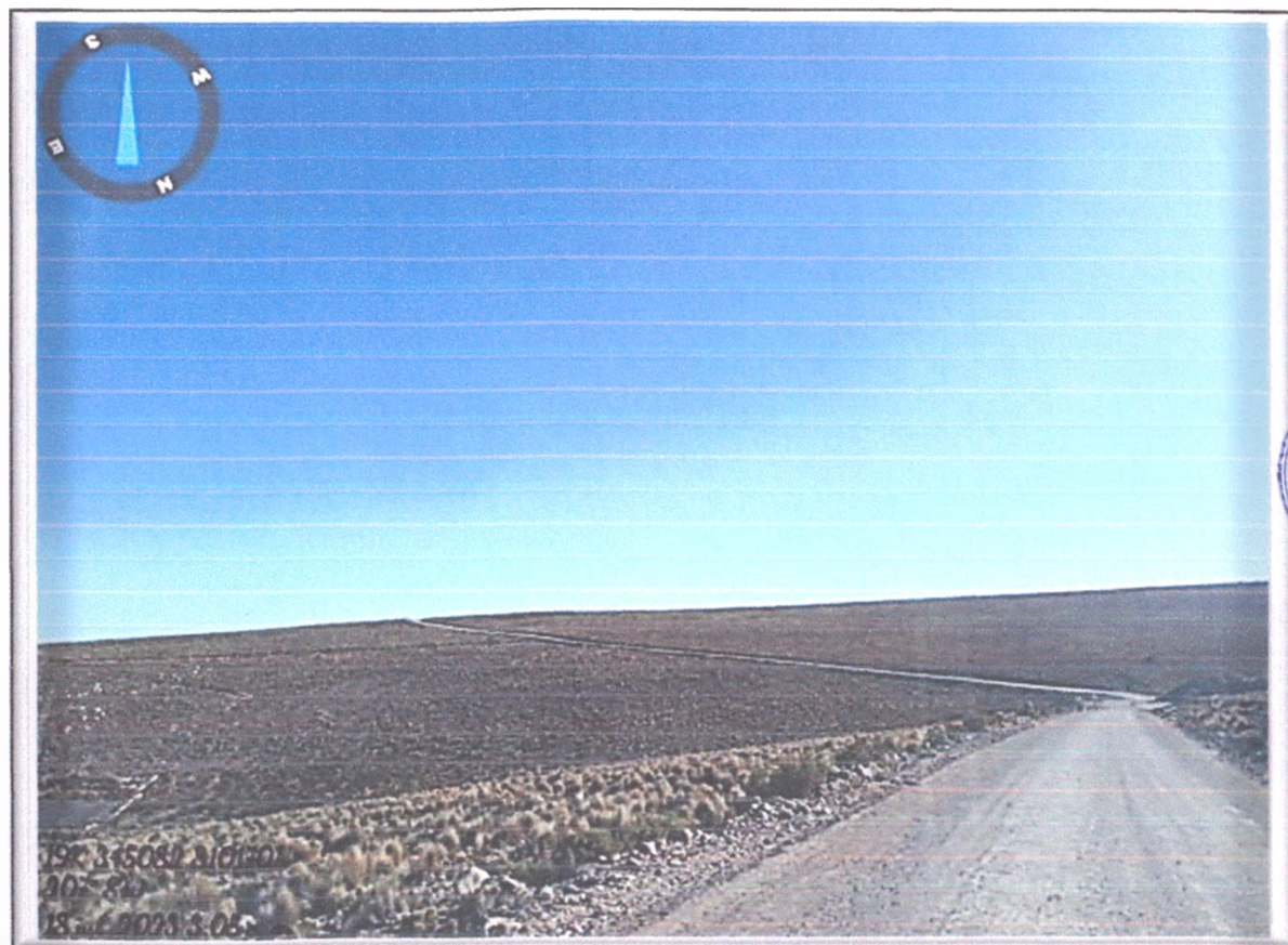
FOTO N° 101: Plataforma de rodadura presenta ahuellamiento y desgaste por erosión.
