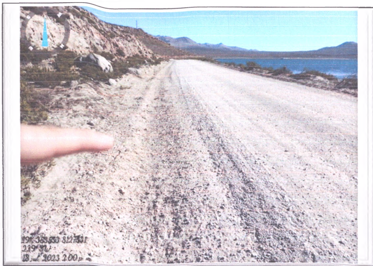
FOTO N° 38: Cuneta totalmente saturada de piedras, arena y piedras.
