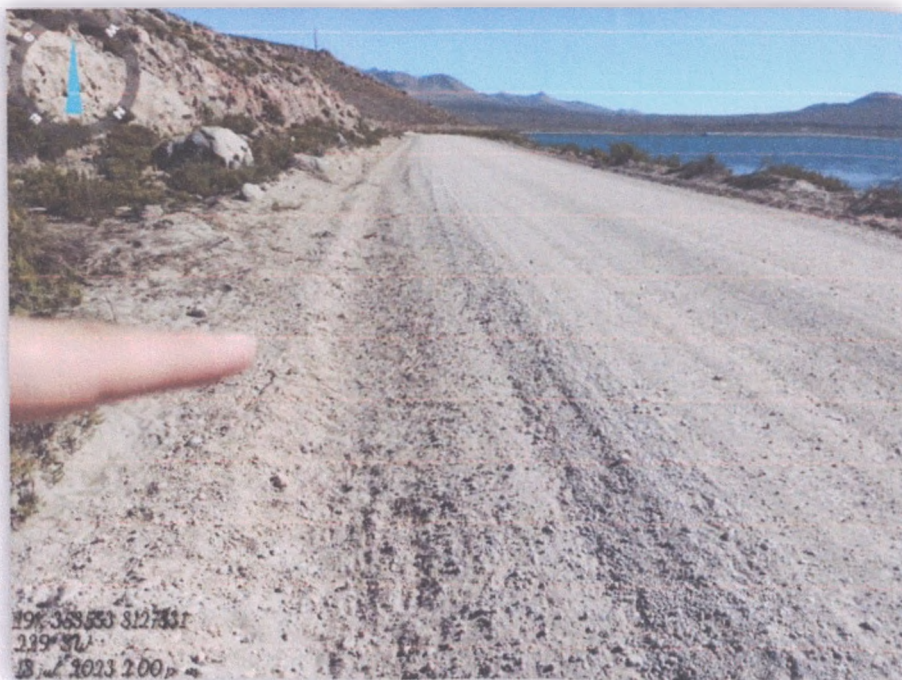
Imagen N° 02: En la imagen se muestra cunetas no revestidas saturadas de piedra, arena y tierra M.I.
