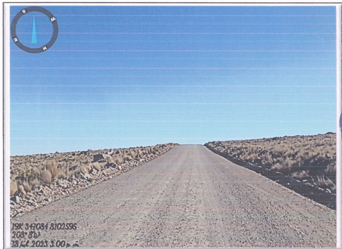
FOTO N° 99: Plataforma de rodadura presenta ahuellamiento y desgaste por erosión.
