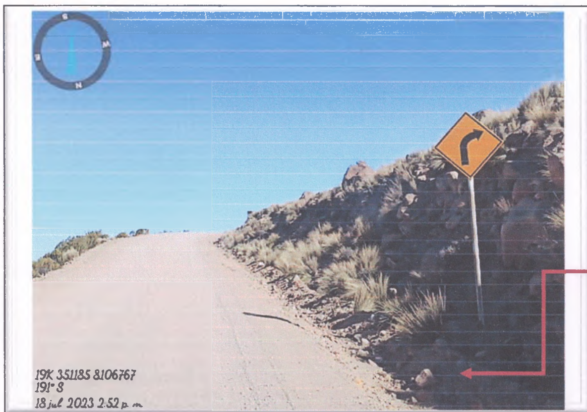
FOTO N° 90: Vista de cuneta saturada de piedras, arena, tierra y plantas en M.D.
