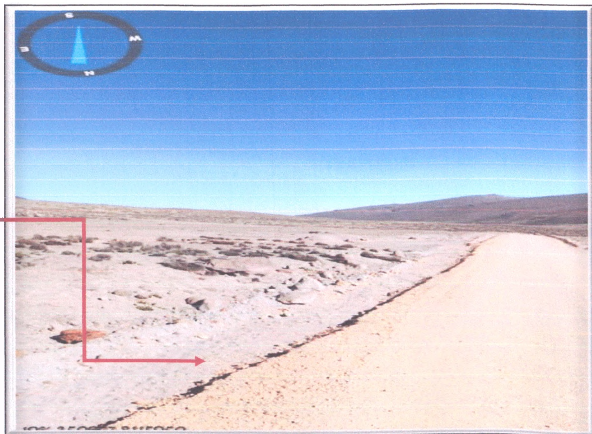
FOTO N° 71: Cuneta Saturada de piedras, arena y tierra en M.I.
