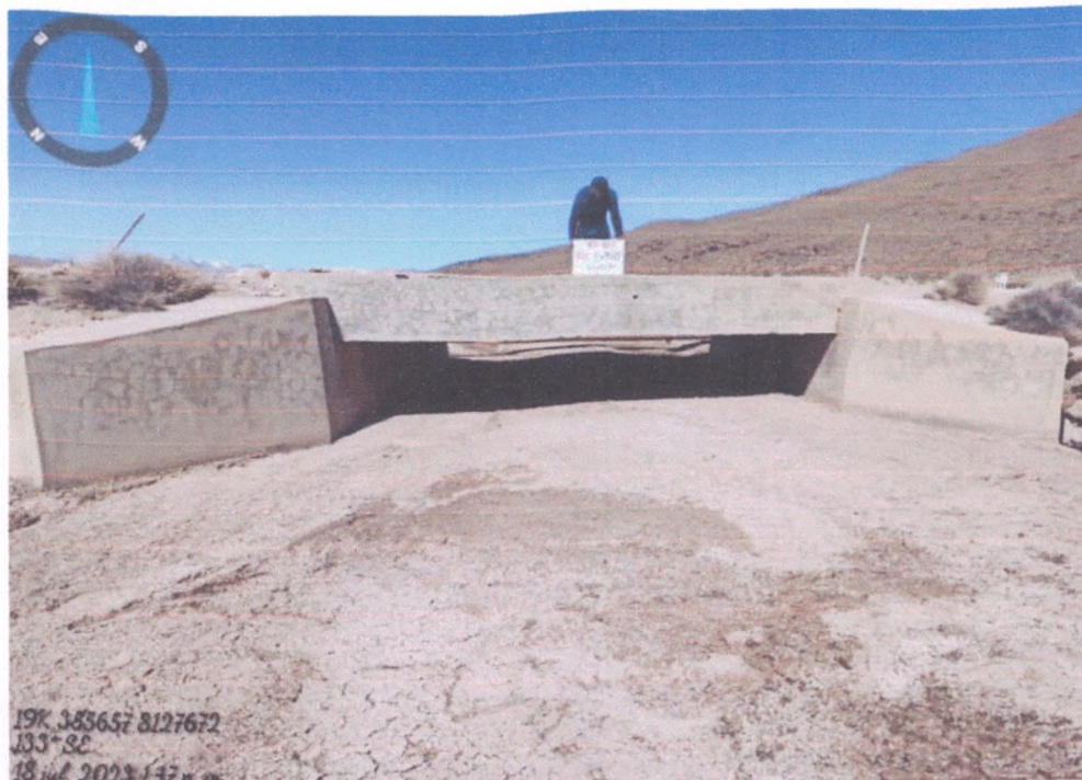
Imagen N° 03: En la imagen se muestra el pontón saturado de piedras y arena.
