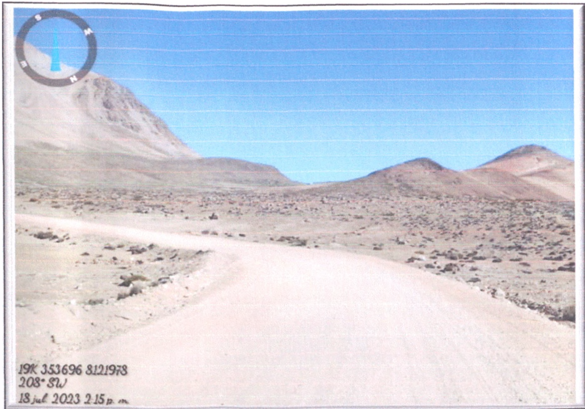
FOTO N° 54: Plataforma de rodadura con desgaste por erosión y lluvias de temporada.
