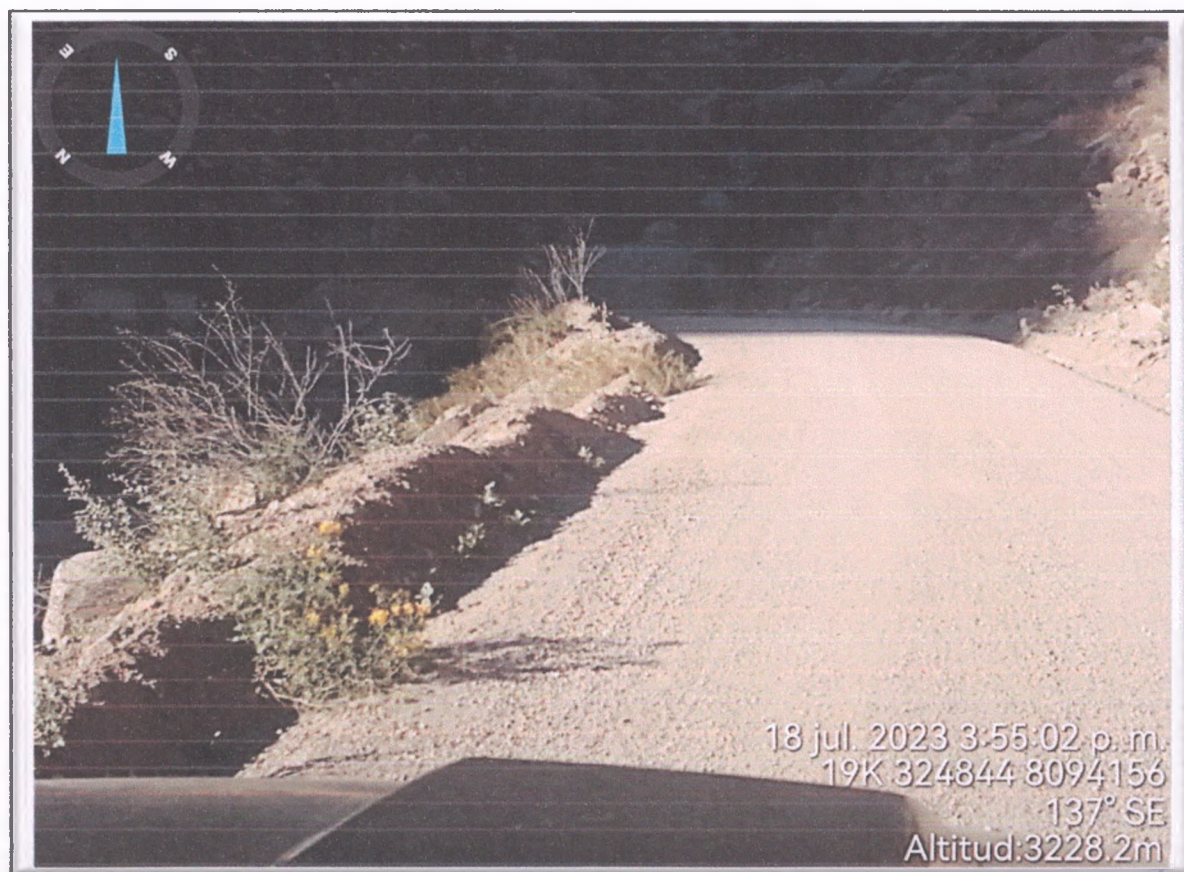
FOTO N° 147: Plataforma de rodadura presenta ahuellamiento y desgaste por erosión. Km. 83+200
