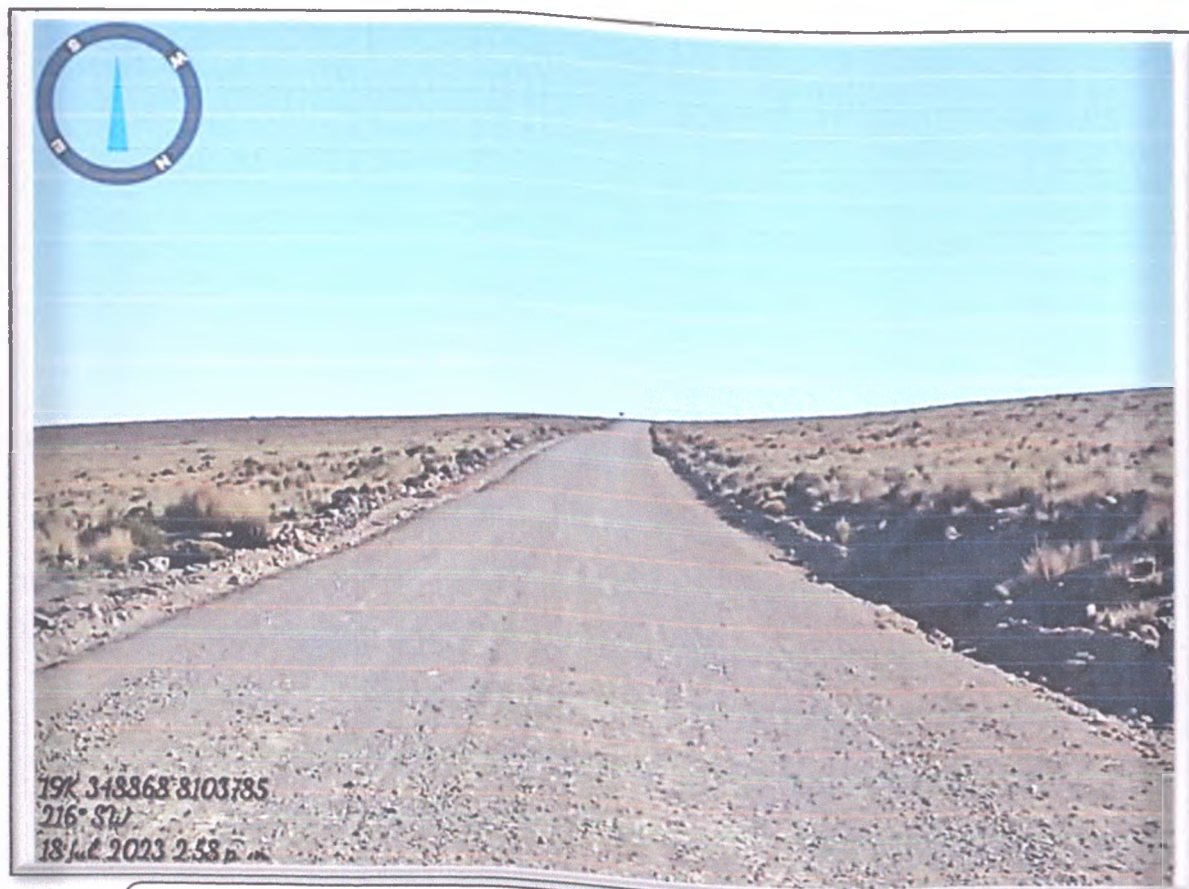
FOTO N° 95: Plataforma de rodadura presenta ahuellamiento y desgaste por erosión.
