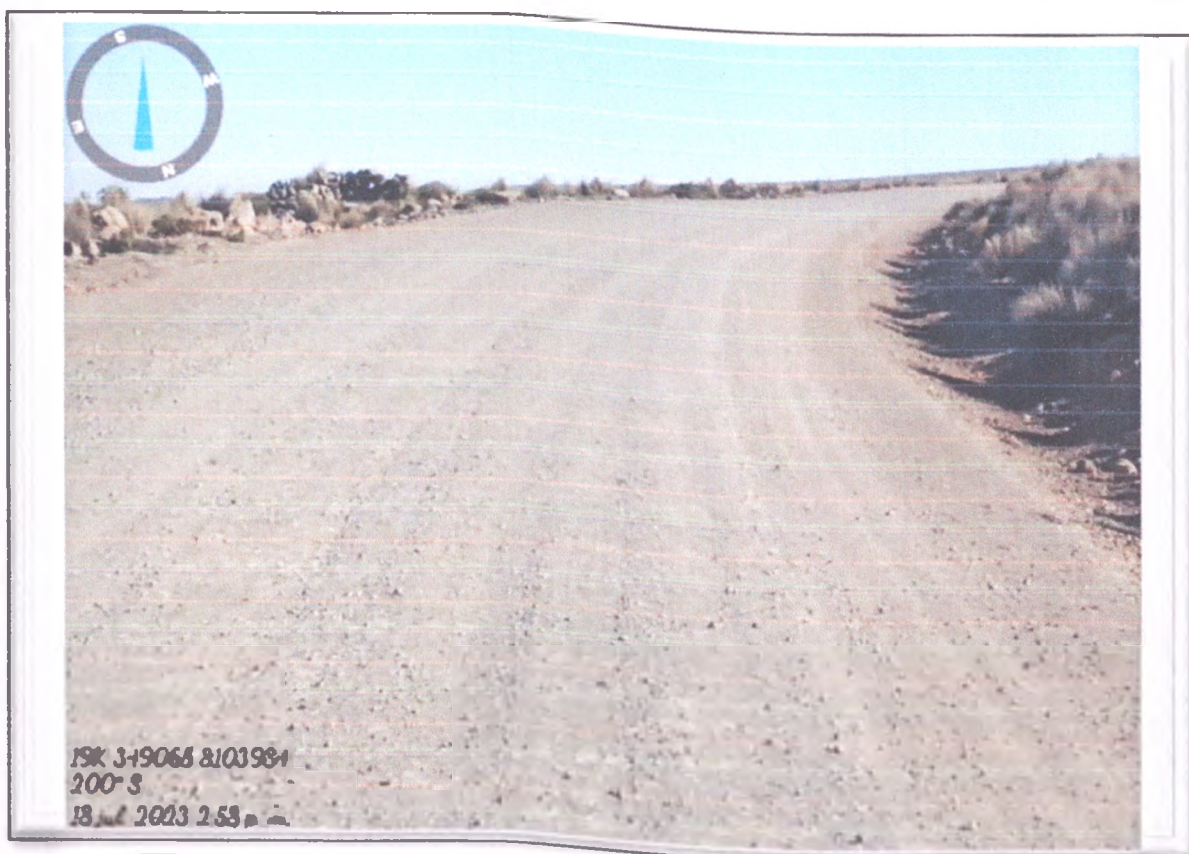
FOTO N° 94: Plataforma de rodadura presenta ahuellamiento y desgaste por erosión.
