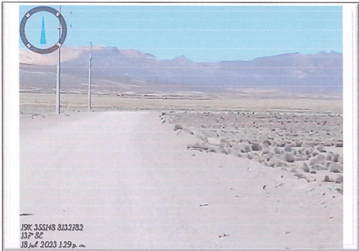
FOTO N° 05: Plataforma de rodadura con erosión y desgaste.
