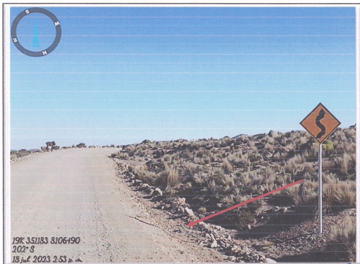
FOTO N° 91: Vista de cuneta saturada de piedras, arena, tierra y plantas en M.D.
