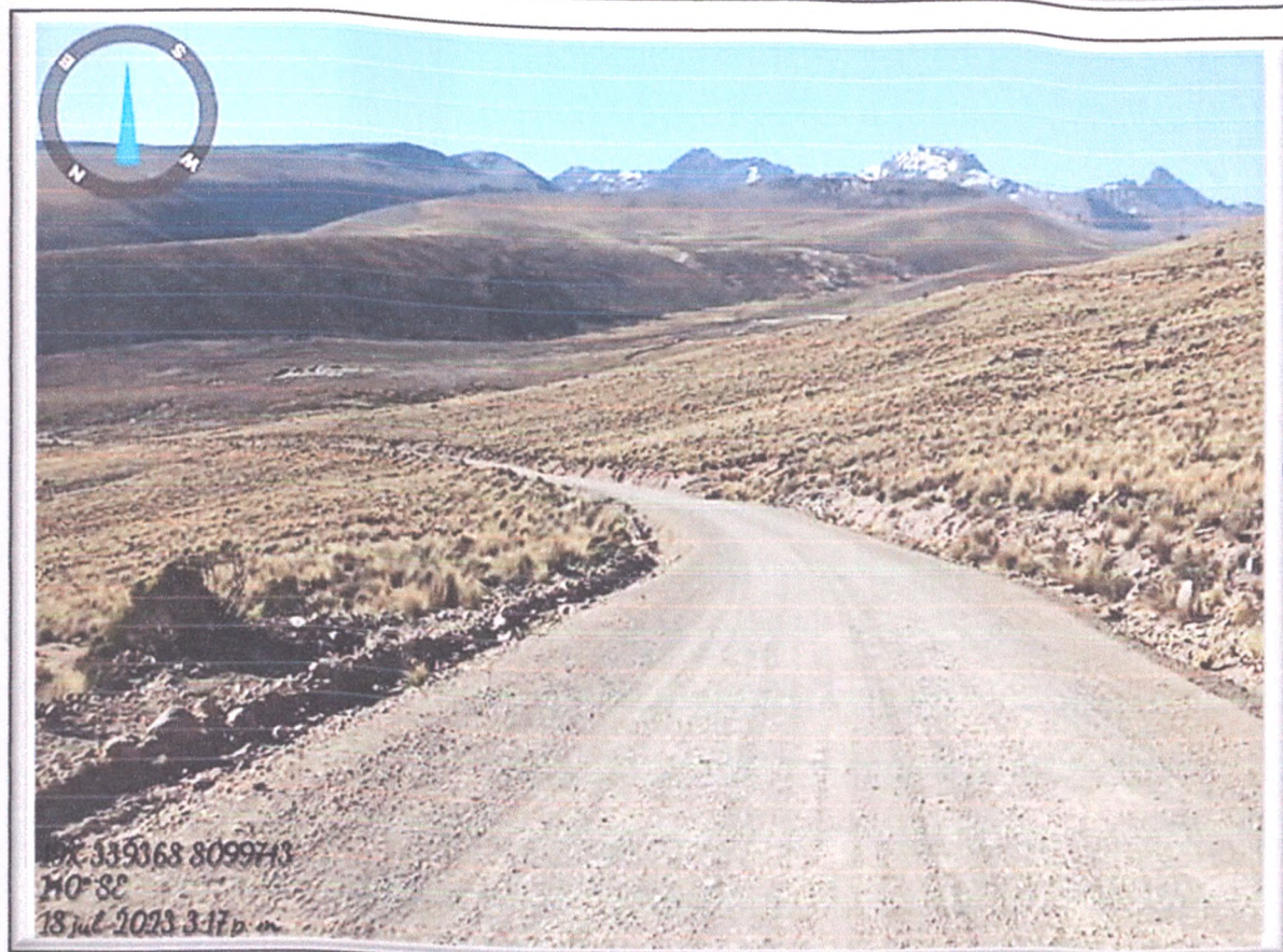
FOTO Nº 113: Plataforma de rodadura presenta ahuellamiento y desgaste por erosión, Km. 48+000
