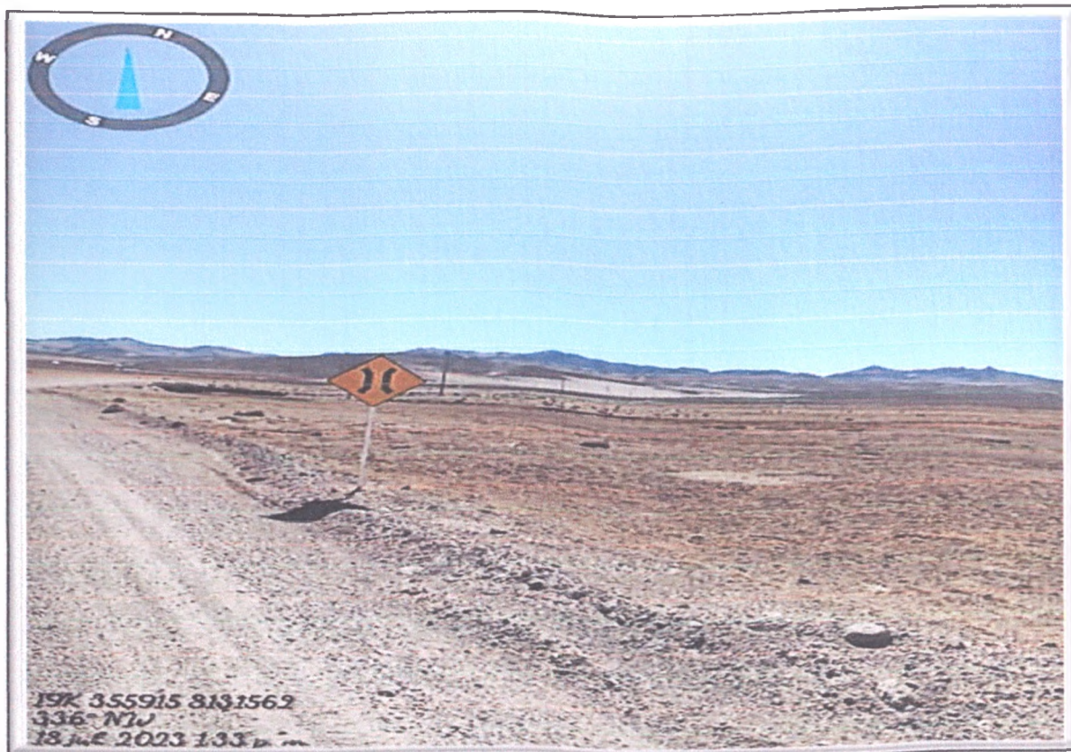
FOTO N° 10: Vista de señal preventiva y cuneta saturada de piedras y arena M.D.
