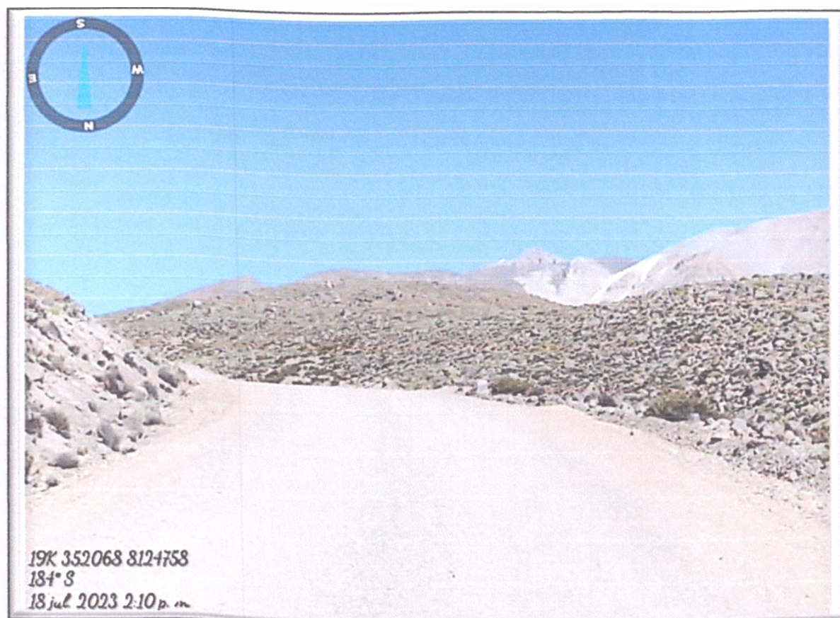
FOTO N° 51: Plataforma de rodadura con desgaste por erosión y lluvias de temporada.
