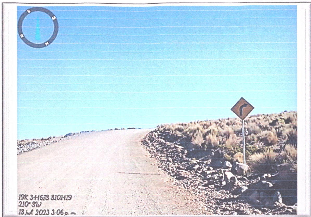
FOTO N° 102: Vista de Cuneta saturada de piedras, arena y tierra en M.D.
