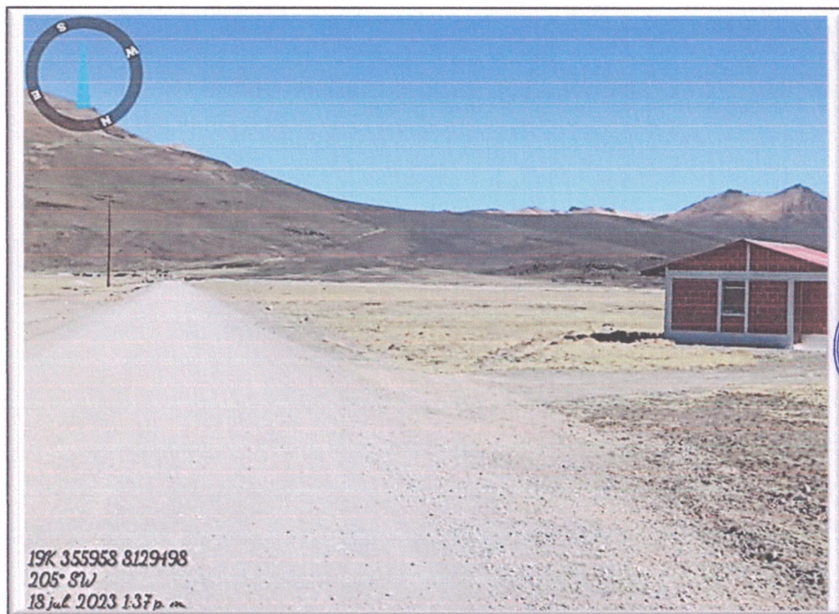
FOTO N° 13: Desgaste de Plataforma y cuneta saturada de piedras y arena
