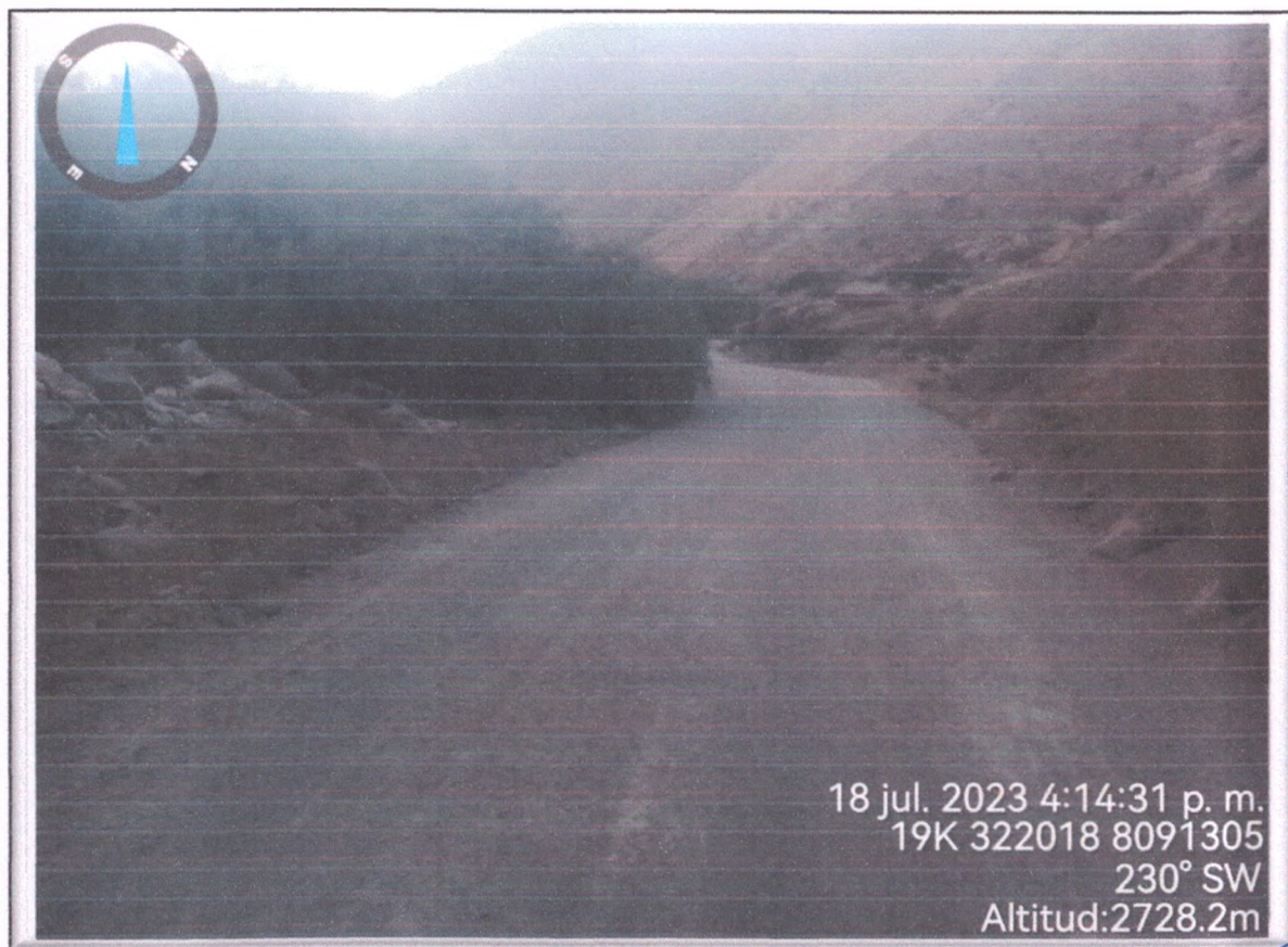
FOTO N° 155: Plataforma de rodadura presenta ahuellamiento y desgaste por erosión, zona de plantas para roce, Km. 86+150
