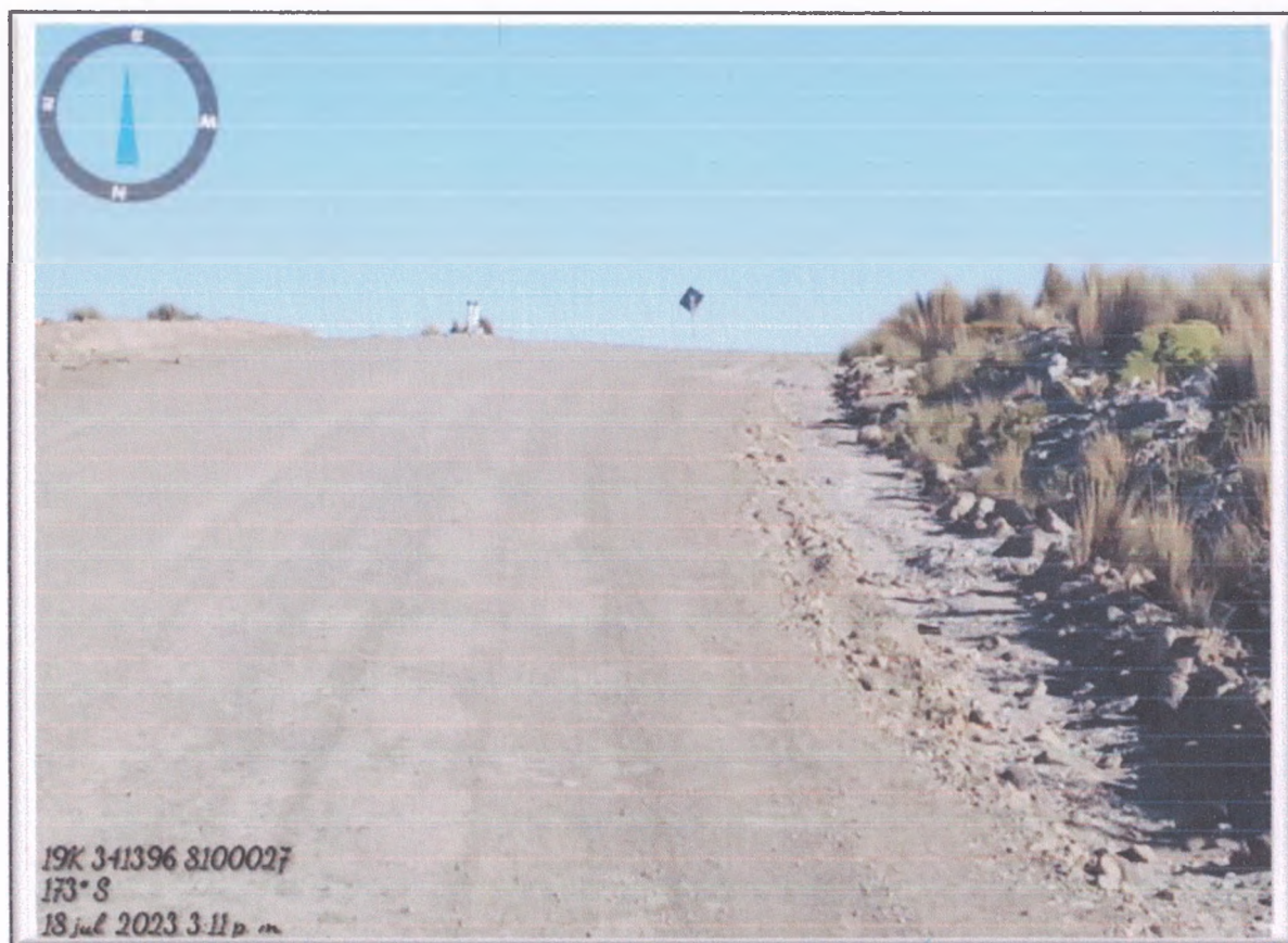
FOTO N° 105: Vista de Cuneta saturada de piedras, arena y tierra en M.D.
