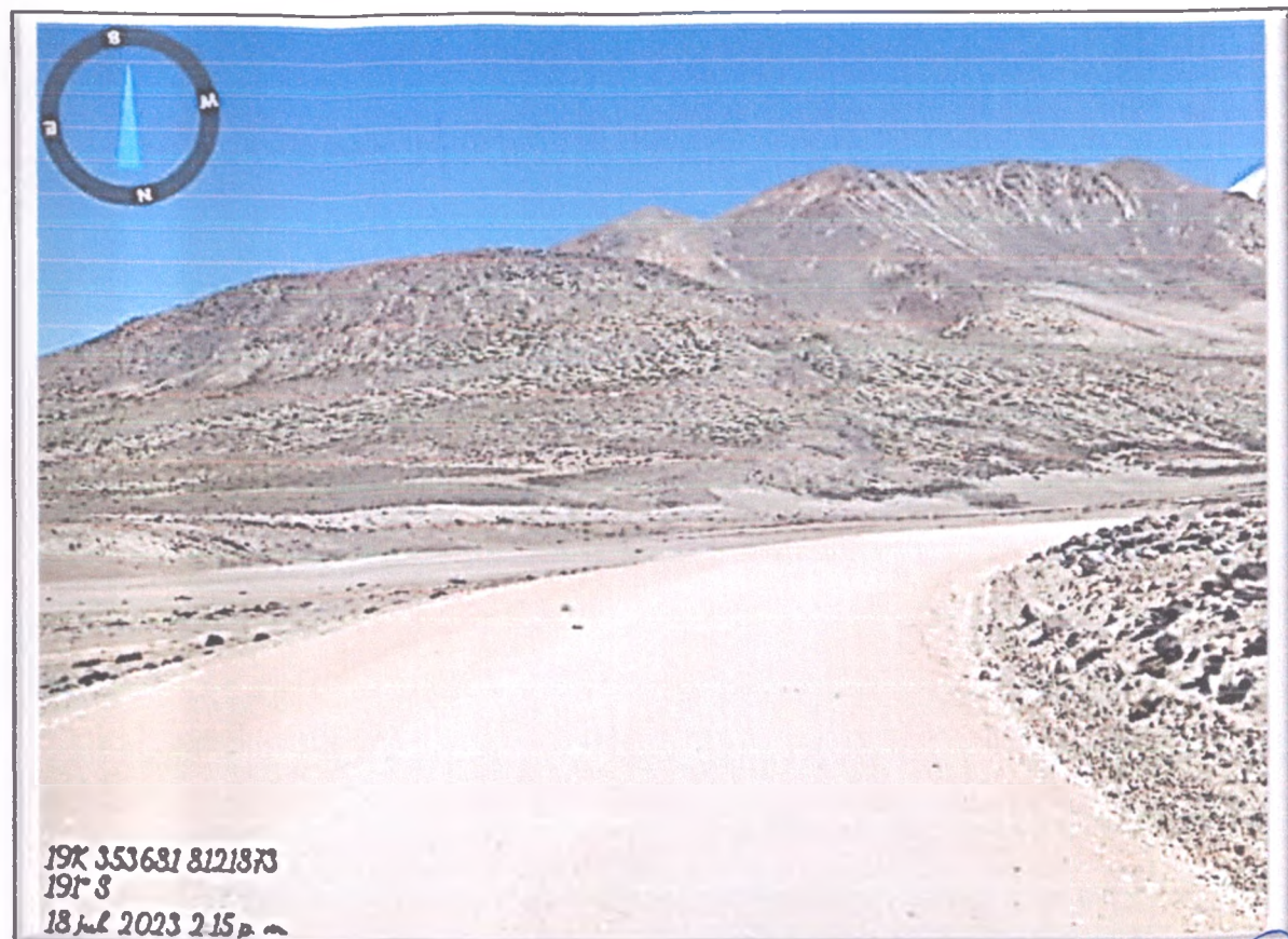
FOTO N° 55: Plataforma de rodadura con desgaste por erosión y lluvias de temporada.
