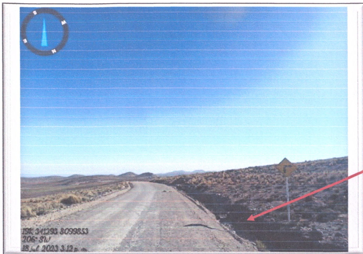
FOTO N° 108: Vista de Cuneta saturada de piedras, arena, tierra y plantas en M.D.
