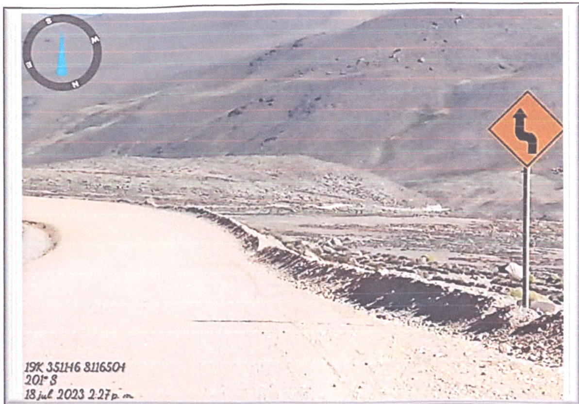
FOTO N° 70: Plataforma de rodadura con desgaste por erosión y lluvias de temporada y señal preventiva M.D.
