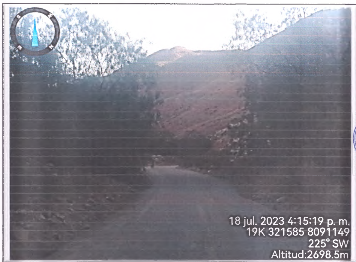
FOTO N° 159: Plataforma de rodadura presenta ahuellamiento y desgaste por erosión, zona de plantas para roce, Km. 87+050
