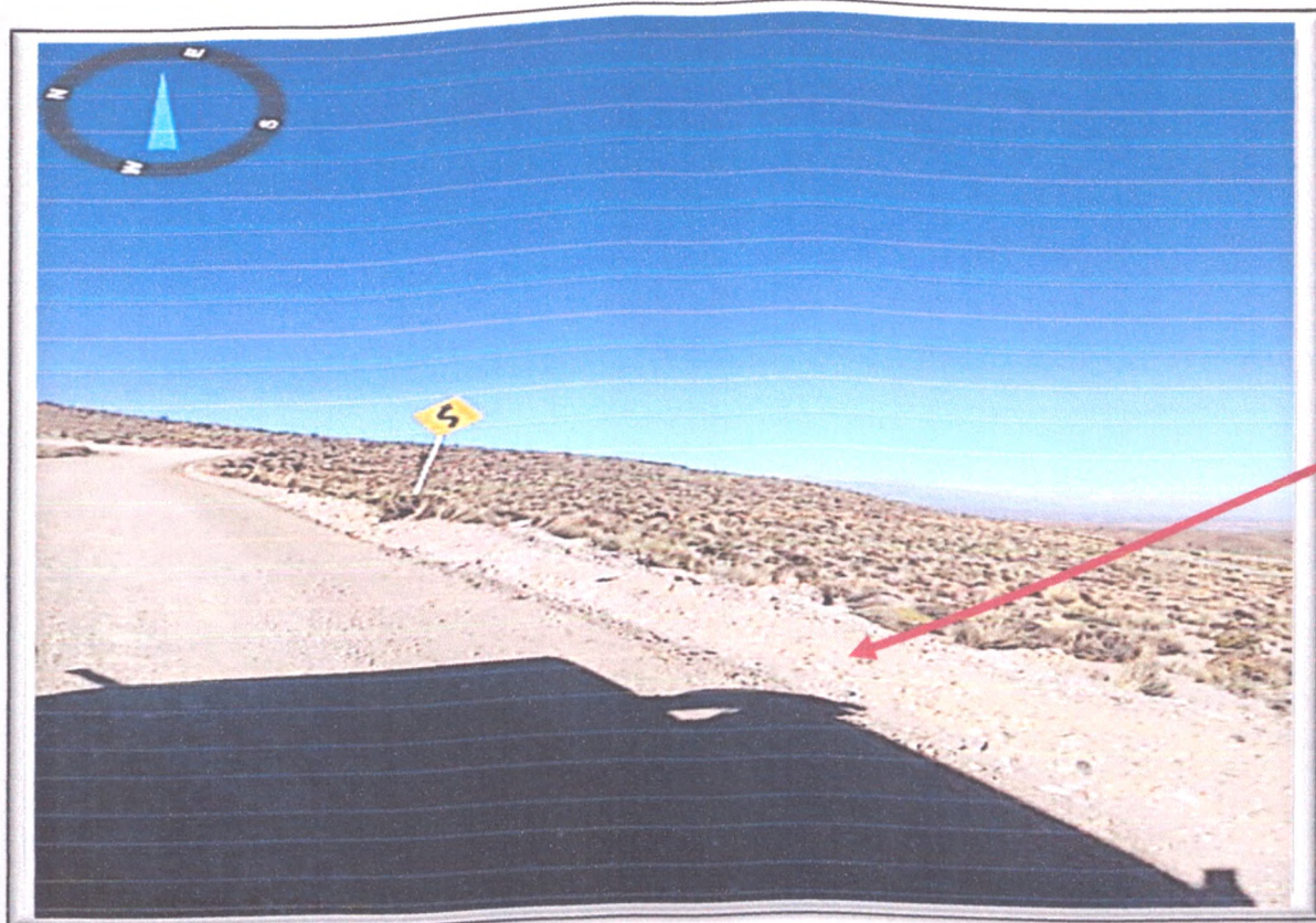
FOTO N° 110: Vista de Cuneta saturada de piedras, arena , tierra y plantas en M.D.
