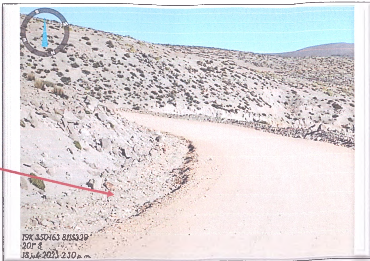
FOTO N° 73: Cuneta Saturada de piedras, arena y tierra en M.I.
