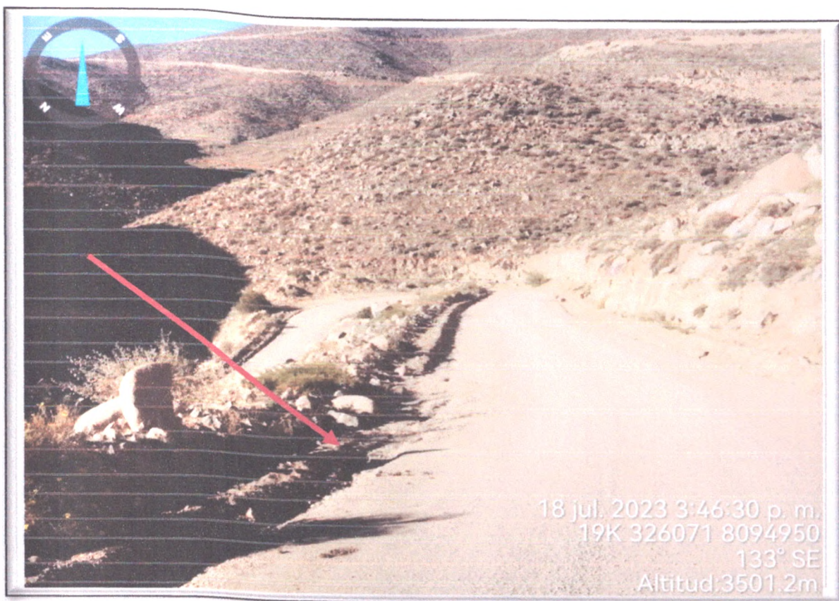
FOTO N° 140: Vista de Cuneta saturada de piedras, arena y tierra en MI.
