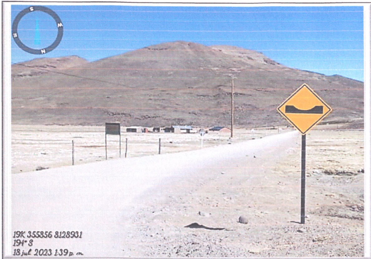
FOTO N° 18: Plataforma con desgaste con presencia mayor de material granular y señal preventiva.
