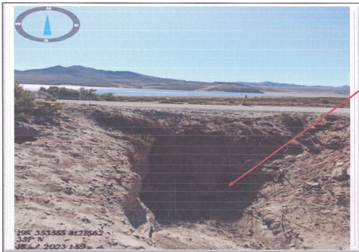
FOTO N° 36: Vista de Alcantarilla saturada de piedras , arena, tierra y basuras.
