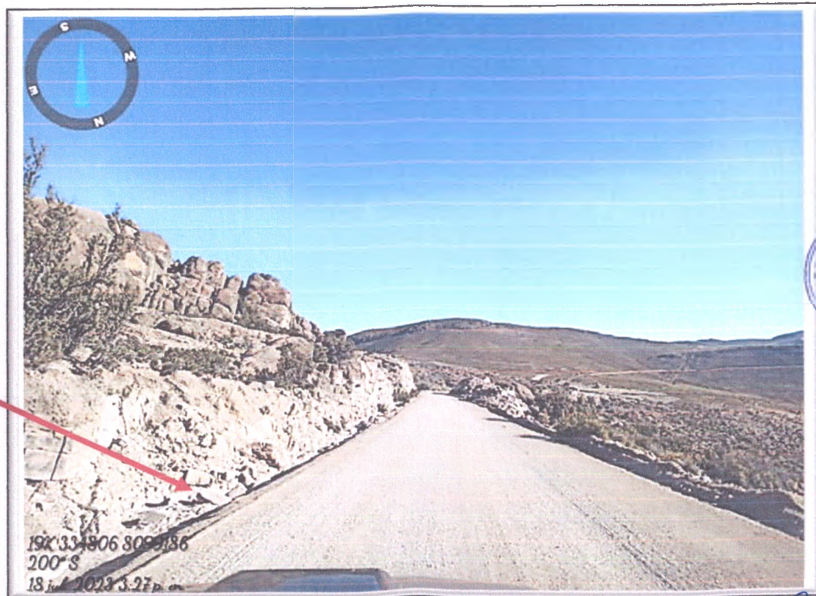
FOTO N° 127: Vista de Cuneta saturada de piedras, arena y tierra en M.I.
