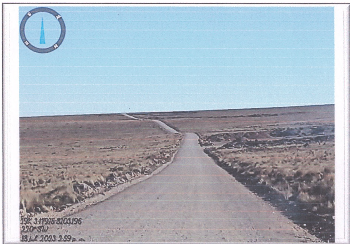
FOTO N° 98: Plataforma de rodadura presenta ahuellamiento y desgaste por erosión.
