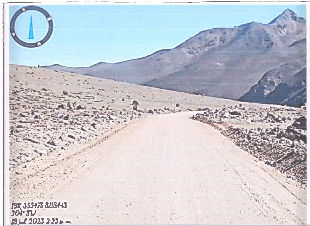
FOTO N° 65: Plataforma de rodadura con desgaste por erosión y lluvias de temporada.
