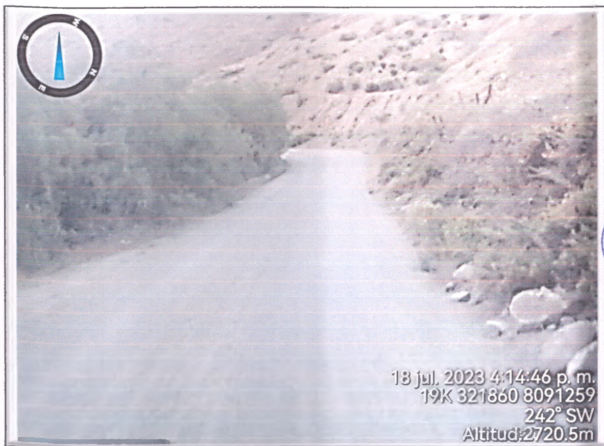
FOTO N° 157: Plataforma de rodadura presenta ahuellamiento y desgaste por erosión, zona de plantas para roce, Km. 86+930
