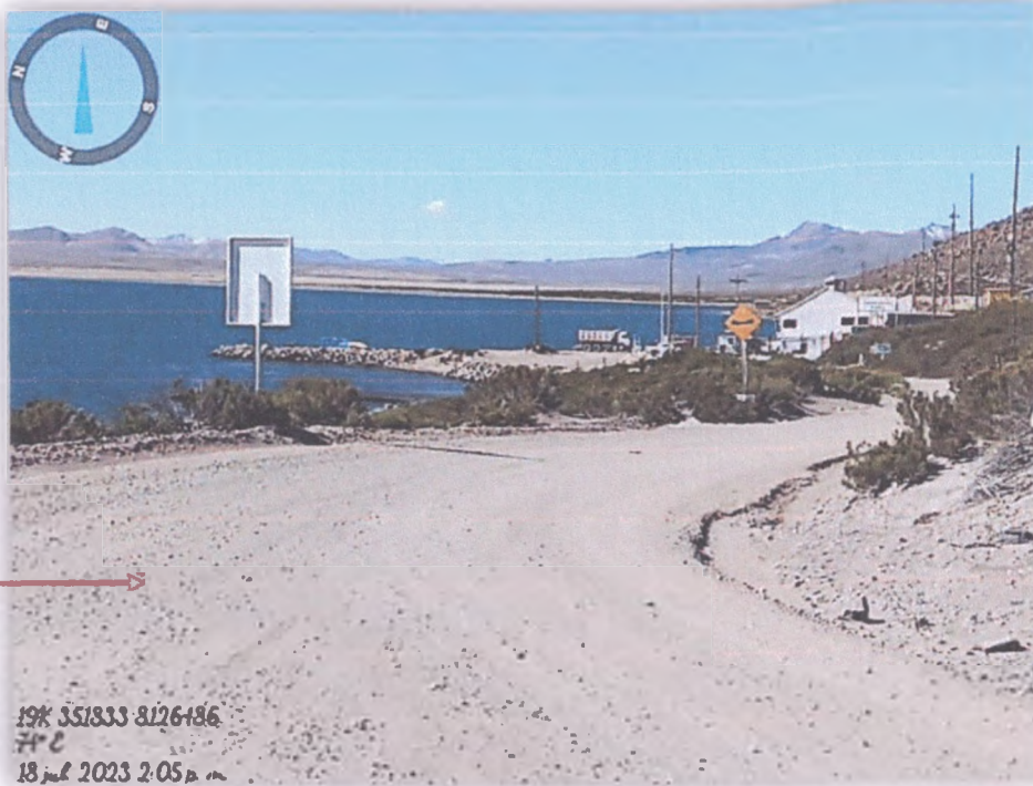
Imagen N° 03: En la imagen se muestra la plataforma de rodadura con desgaste por erosión, lluvias de temporada.
