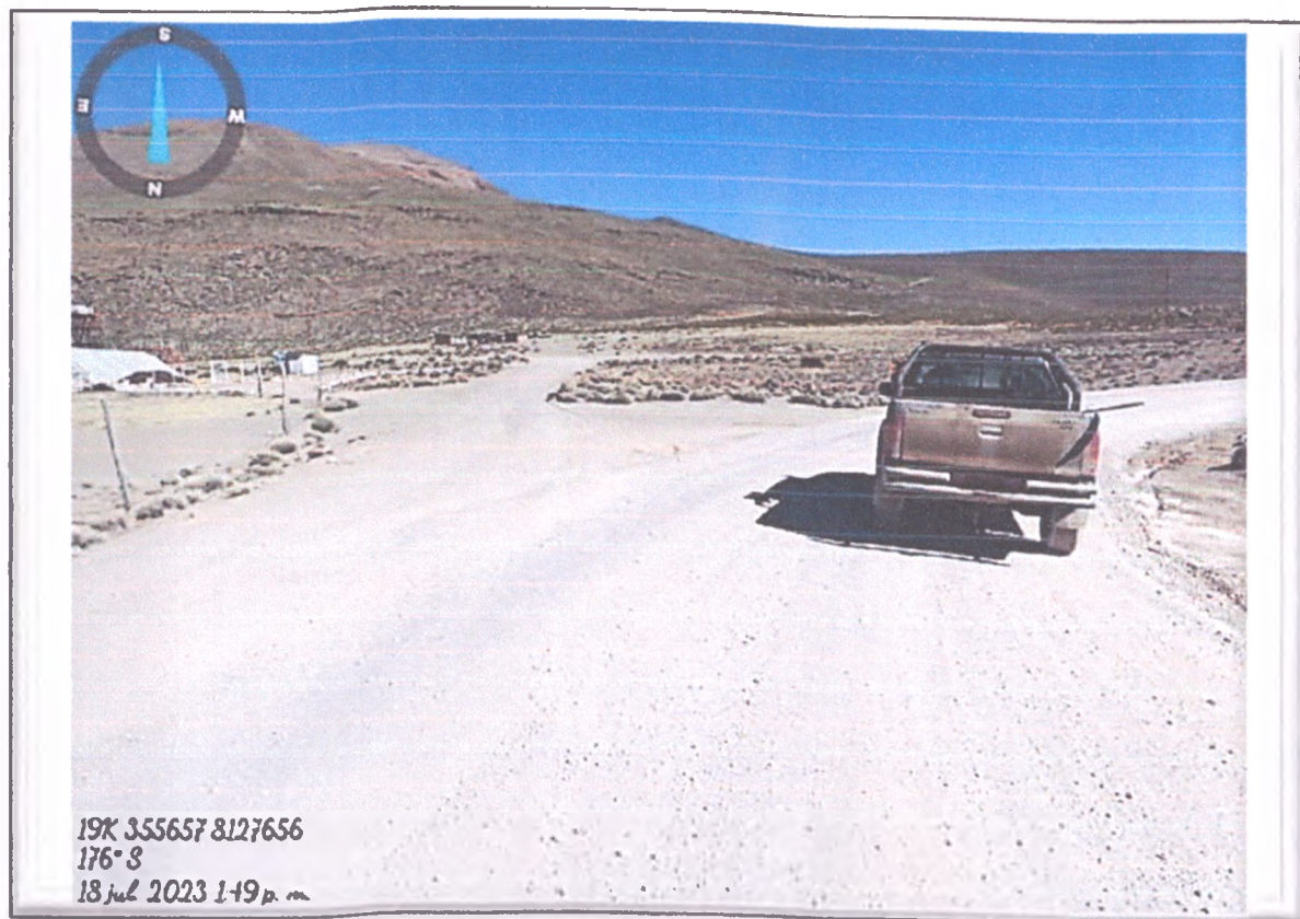
FOTO N° 26: Plataforma de rodadura con desgaste por erosión y ahuellamientos por el tránsito vehicular.
