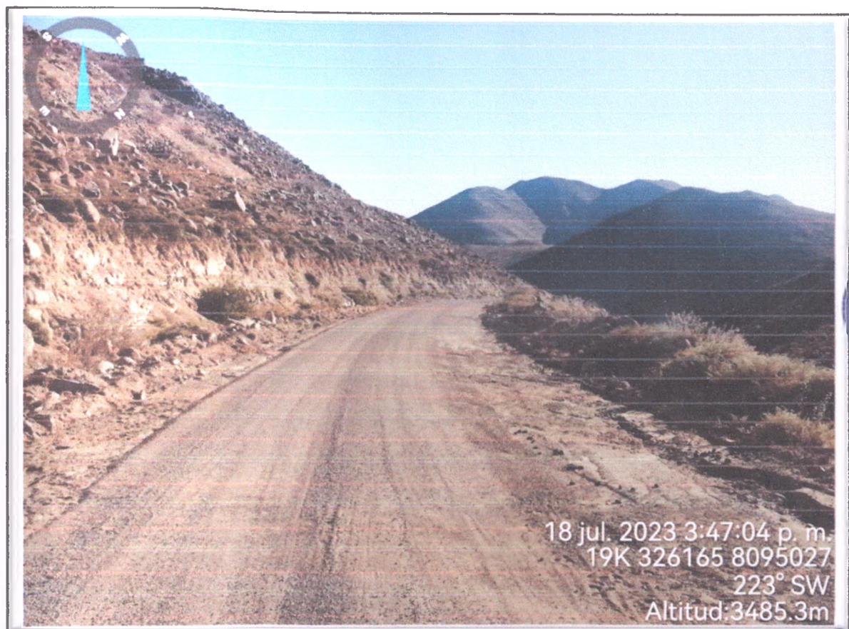
FOTO N° 141: Plataforma de rodadura presenta ahuellamiento y desgaste por erosión. Km. 81+400
