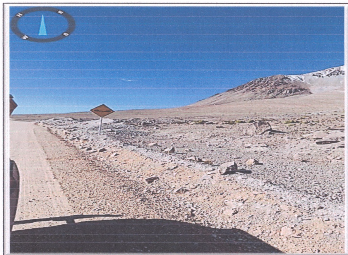
FOTO N° 67: Cuneta saturada de piedras, arena y tierra. M.D.
