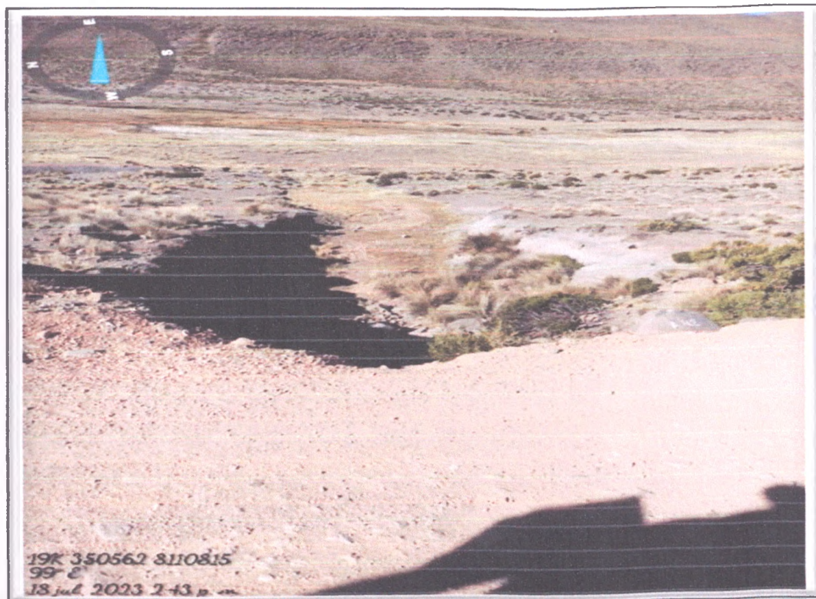
FOTO N° 85: Plataforma de rodadura con desgaste Zona Tacalaya.
