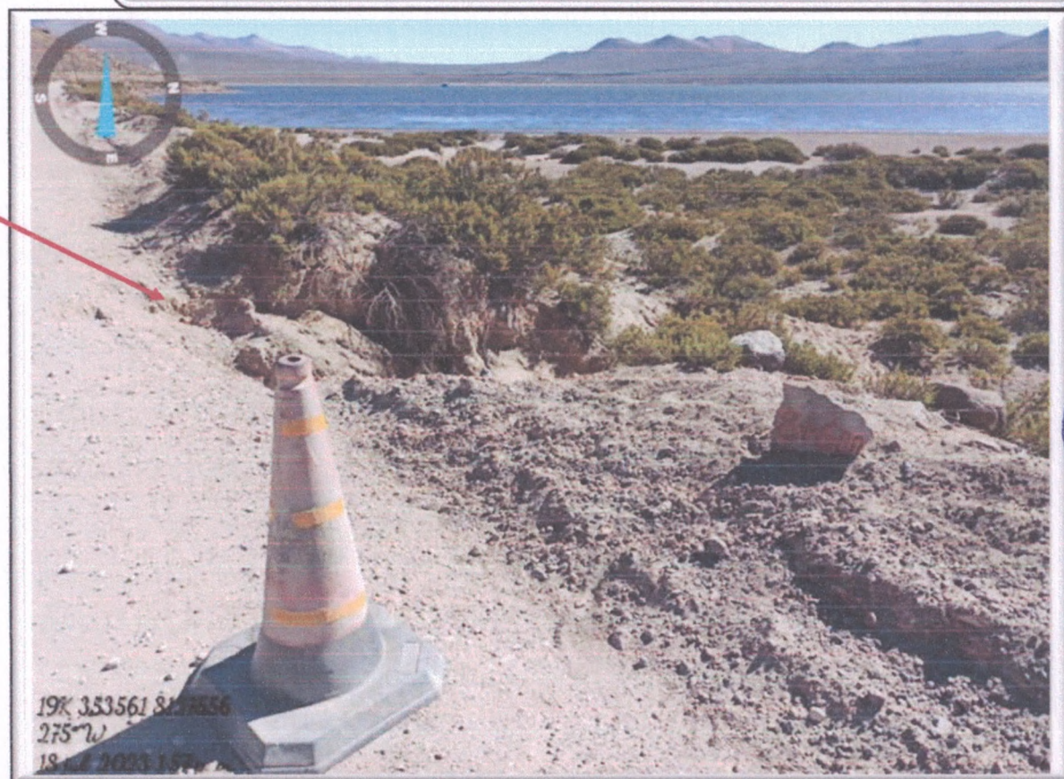
FOTO N° 35: Vista de Alcantarilla saturada de piedras, arena, tierra y basuras.
