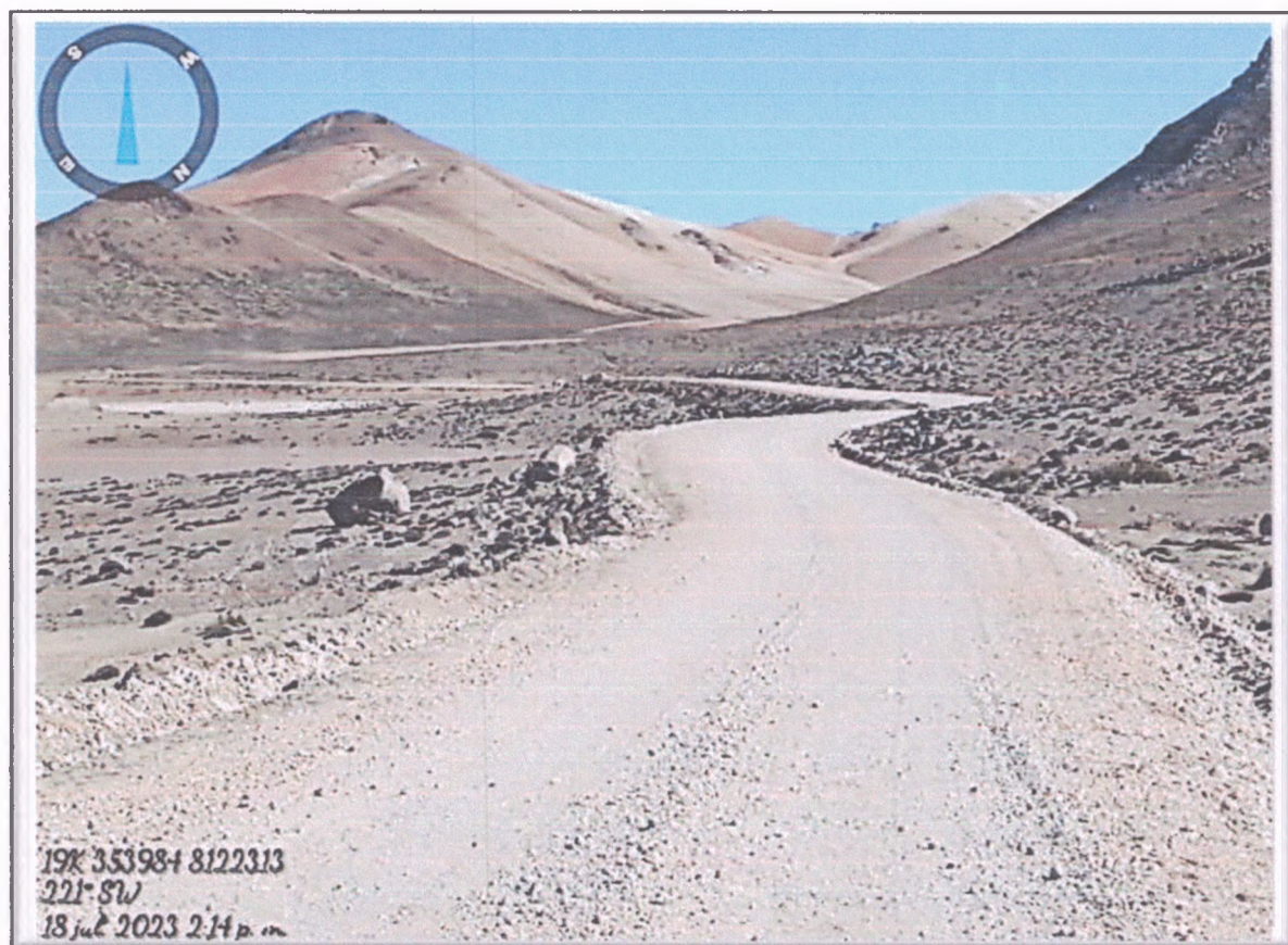
FOTO N° 53: Plataforma de rodadura con desgaste por erosión y lluvias de temporada.
