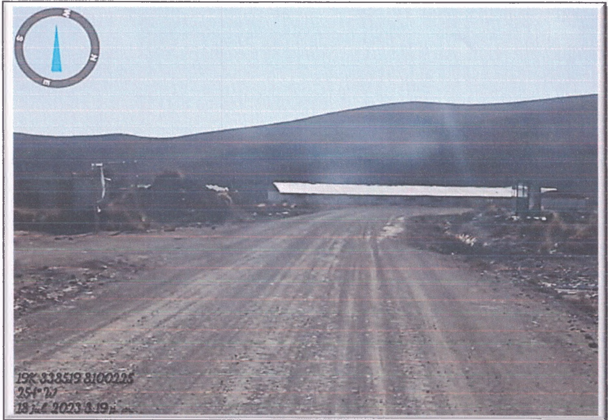
FOTO N° 114: Plataforma de rodadura presenta ahuellamiento y desgaste por erosión. Km. 51+000
