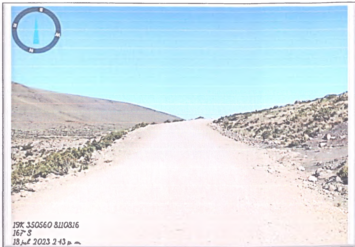
FOTO N° 84: Plataforma de rodadura con desgaste por erosión y lluvias de temporada.
