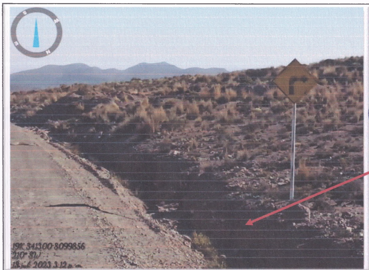
FOTO N° 107: Vista de Cuneta saturada de piedras, arena, tierra y plantas en M.D.
