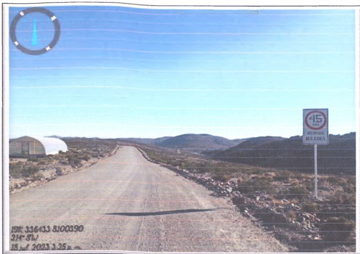
FOTO N° 122: Plataforma de rodadura presenta ahuellamiento y desgaste por erosión. Km. 70+000
