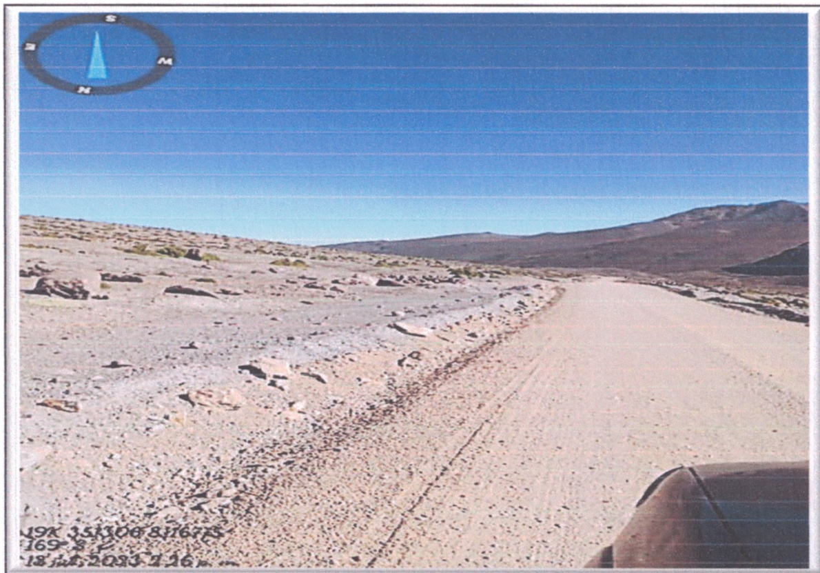
FOTO N° 68: Cuneta saturada de piedras, arena y tierra. M.I.
