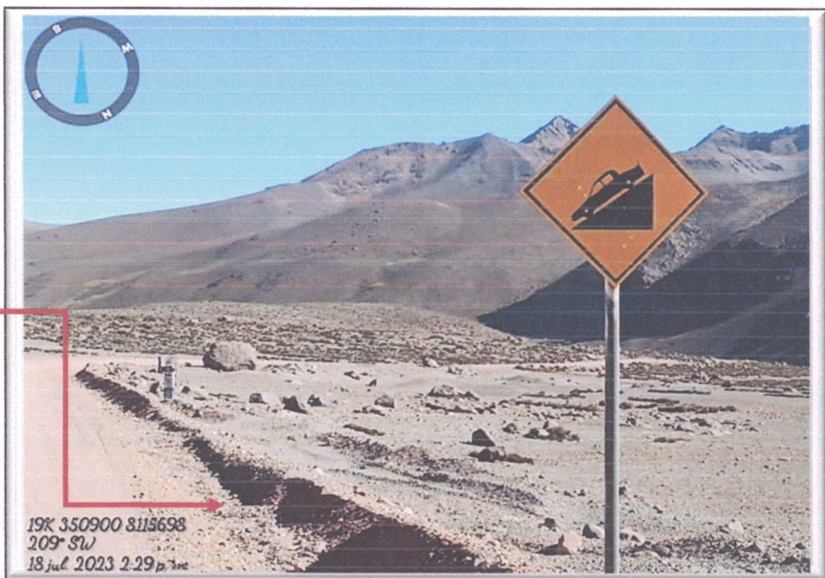
FOTO N° 72: Cuneta Saturada de piedras, arena y tierra en M.D. y señal preventiva
