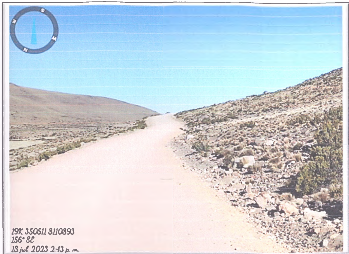
FOTO N° 83: Plataforma de rodadura con desgaste por erosión y lluvias de temporada.
