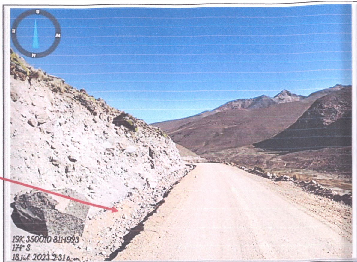
FOTO N° 74: Cuneta Saturada de piedras, arena y tierra en M.I.
