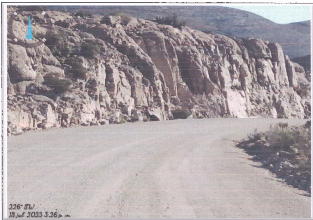
FOTO N° 124: Plataforma de rodadura presenta ahuellamiento y desgaste por erosión.
