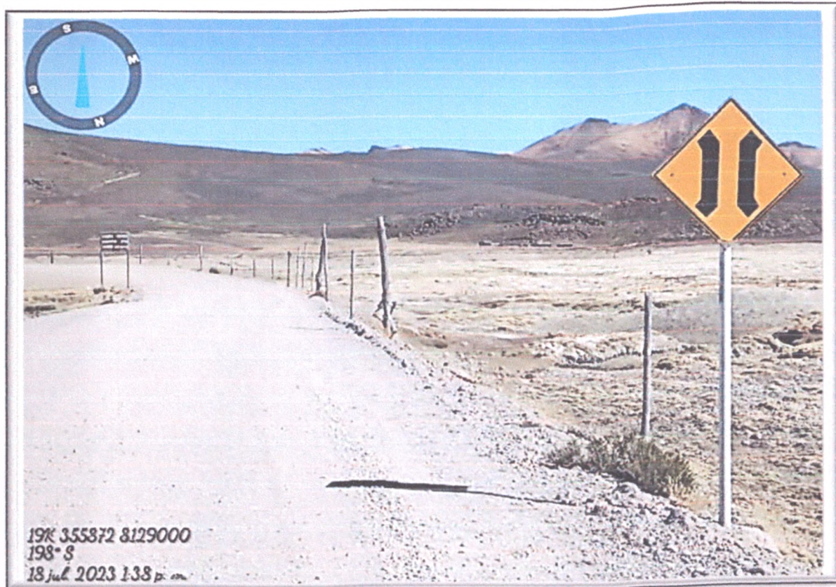
FOTO N° 16: Plataforma con desgaste con presencia mayor de material granular y señal preventiva.
