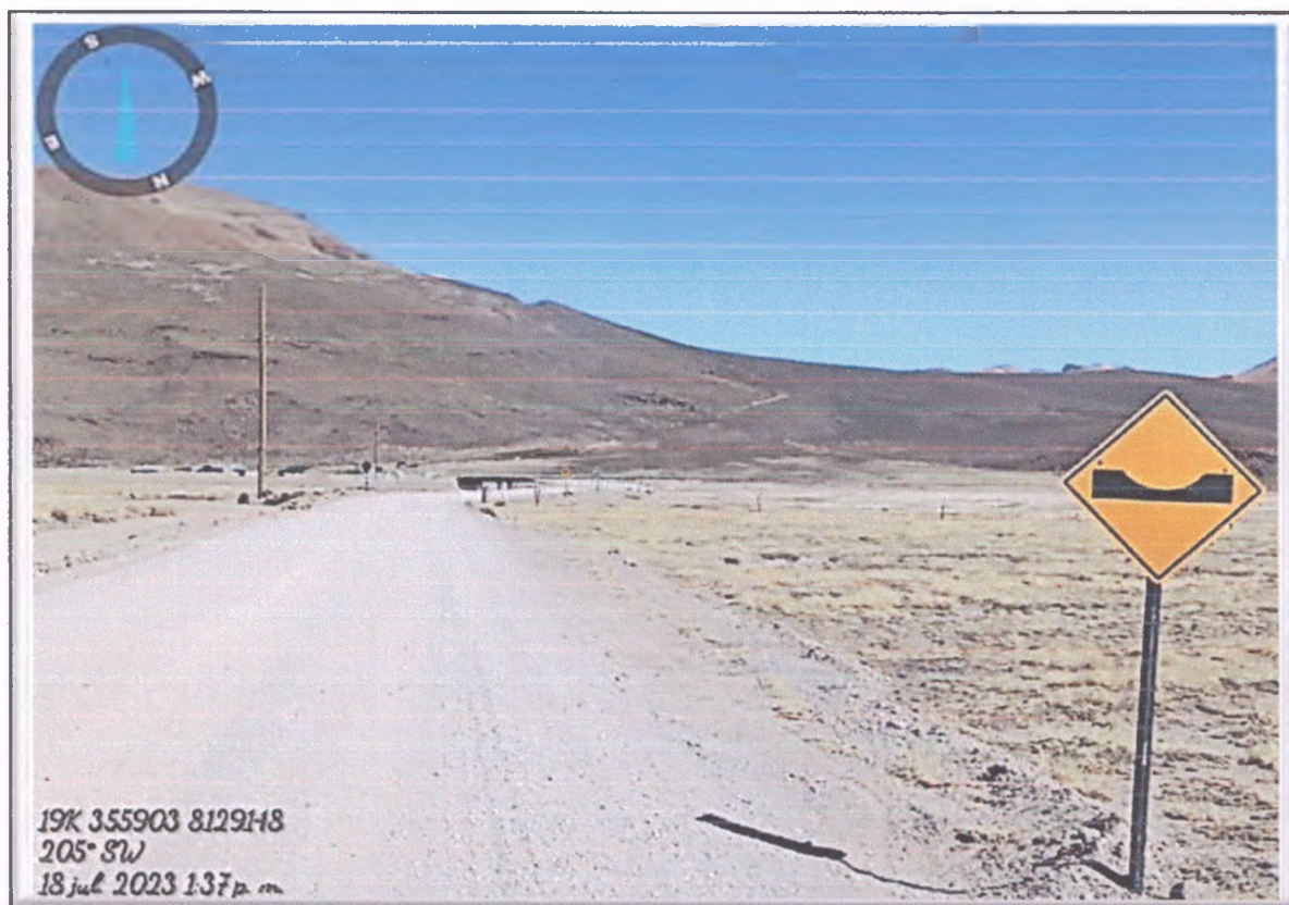
FOTO N° 14: Vista de señal preventiva y cuneta saturada de piedras y arena M.D.
