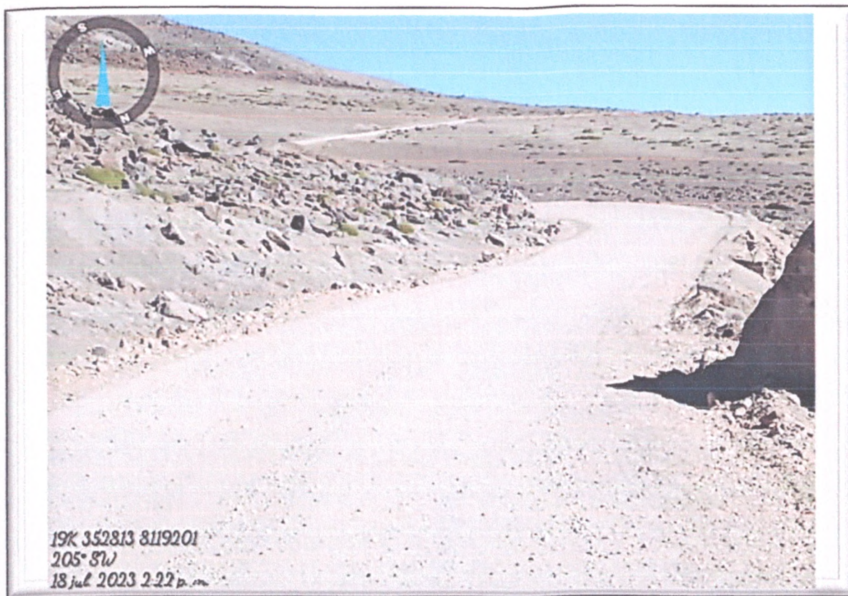
FOTO N° 64: Plataforma de rodadura con desgaste por erosión y lluvias de temporada.
