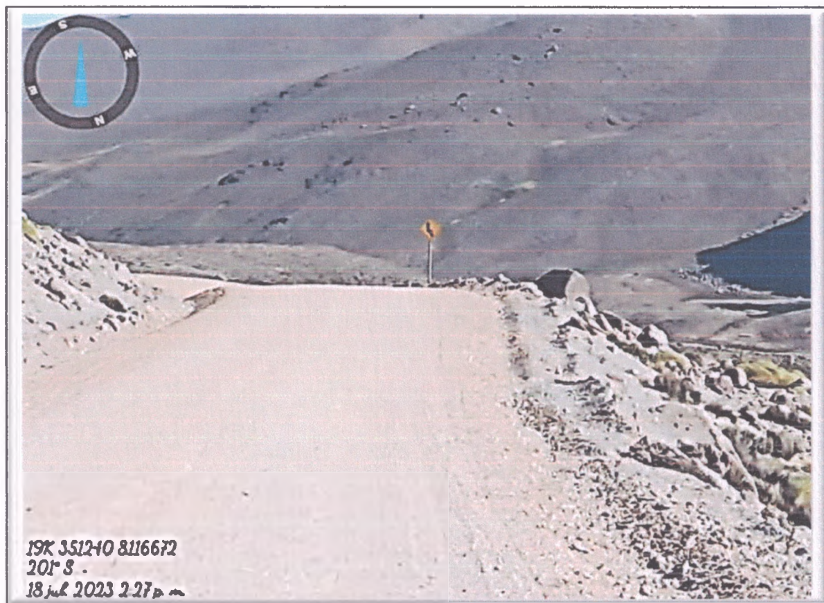
FOTO N° 69: Plataforma de rodadura con desgaste por erosión y lluvias de temporada.
