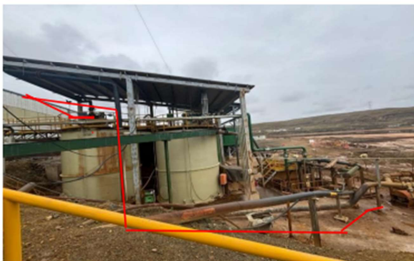
Fig. N°17 En la línea color rojo marca la línea que se instalara con tubería HDPE de 8" hasta el taque distribuidor.
