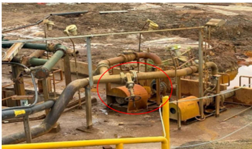
Fig. N°16 En el círculo rojo marca la Y en cual se independizará la línea de 8".
