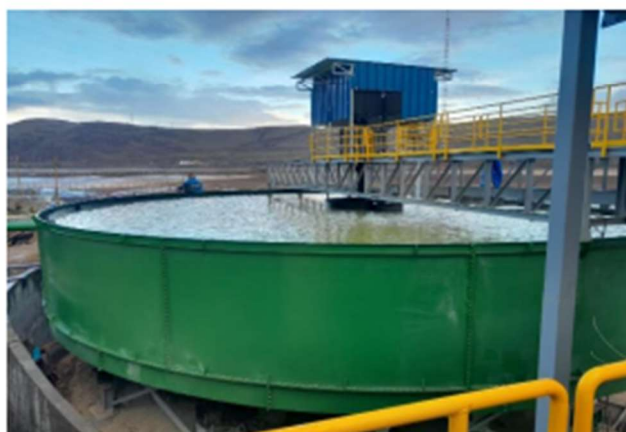
Fig. N°15 Clarificador de 23 de diámetro
