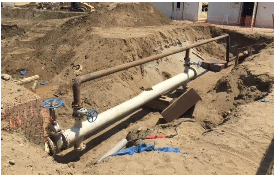
FACILIDADES LADO TIERRA DE LÍNEA SUBMARINA SUR: excavación, trampa de lanzamiento/recepción, líneas de Interconexión, bandejas, válvulas, soportes.
