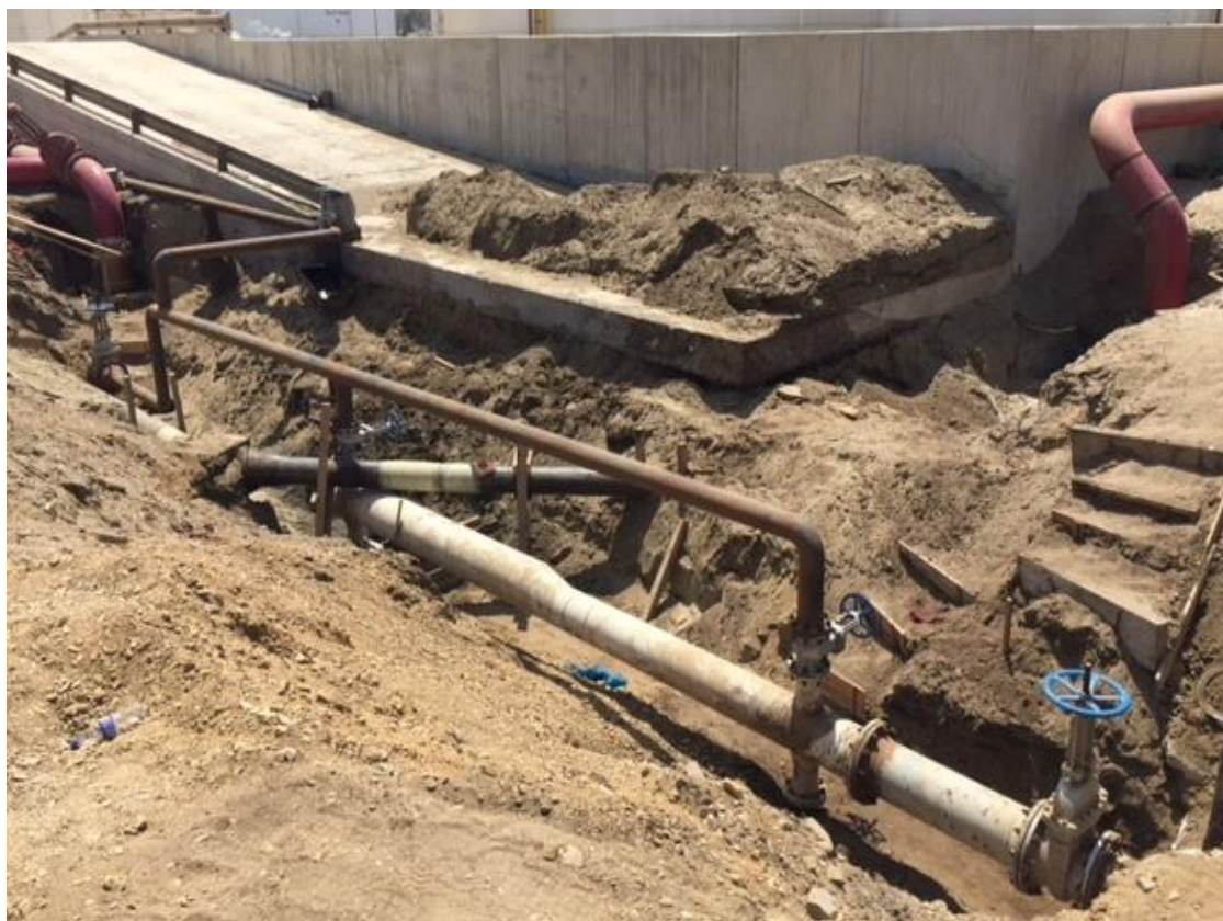
FACILIDADES LADO TIERRA DE LÍNEA SUBMARINA NORTE: excavación, trampa de lanzamiento/recepción, líneas de Interconexión, bandejas, válvulas, soportes.
