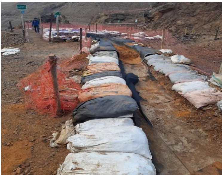
Imagen N° 06: Canales de captación de agua desde la bocamina
