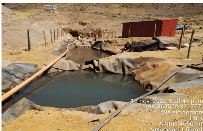
Imagen N° 05: Pozas de sedimentación para realizar mantenimiento
