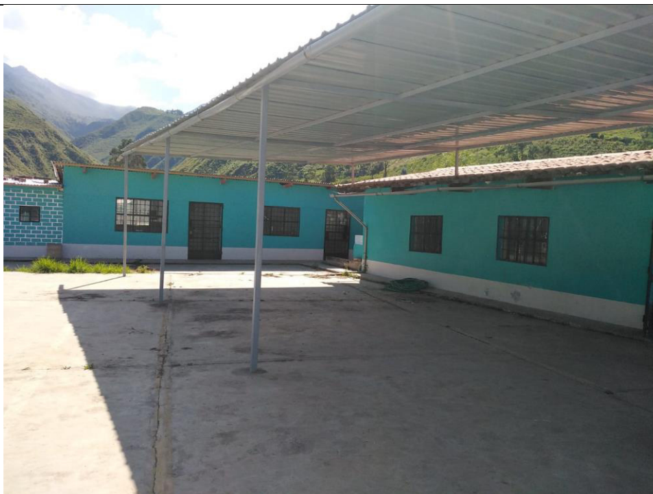
Fotografía N°2: Se visualiza aulas de adobe y pabellón de cocina comedor al fondo, se visualiza estructura metálica con cobertura de calamina, la estructura metálica se apoya parcialmente en el aula y losa.
