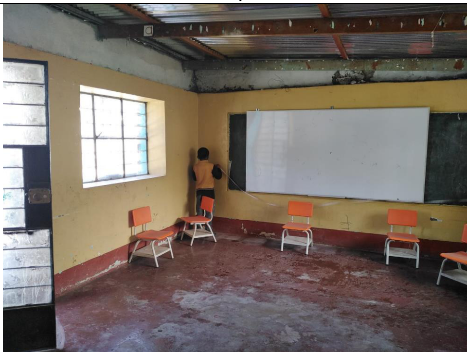
Fotografía N°3: Se visualiza aula de adobe, con cobertura de calamina y estructura de adobe.
