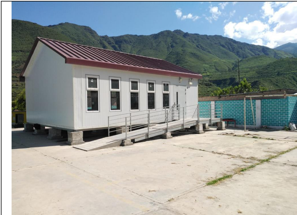
Fotografía N°07: Se visualiza aula prefabricada instalada sobre el patio de concreto ciclópeo, se puede apreciar la altura de muro el cual no representa un elemento de seguridad para la I.E. y sus usuarios.
