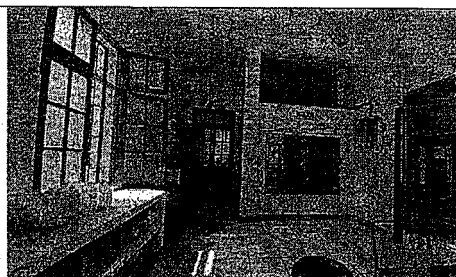
Foto N° 04: Se observa ventanas antiguas, y mesada de concreto con enchape cerámico
