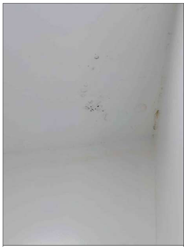
5 APARICIÓN DE MOHO EN CIELO RASO, DEBIDO A LA HUMEDAD ACUMULADA POR INFILTRACIÓN DE AGUA DE LLUVIA.
