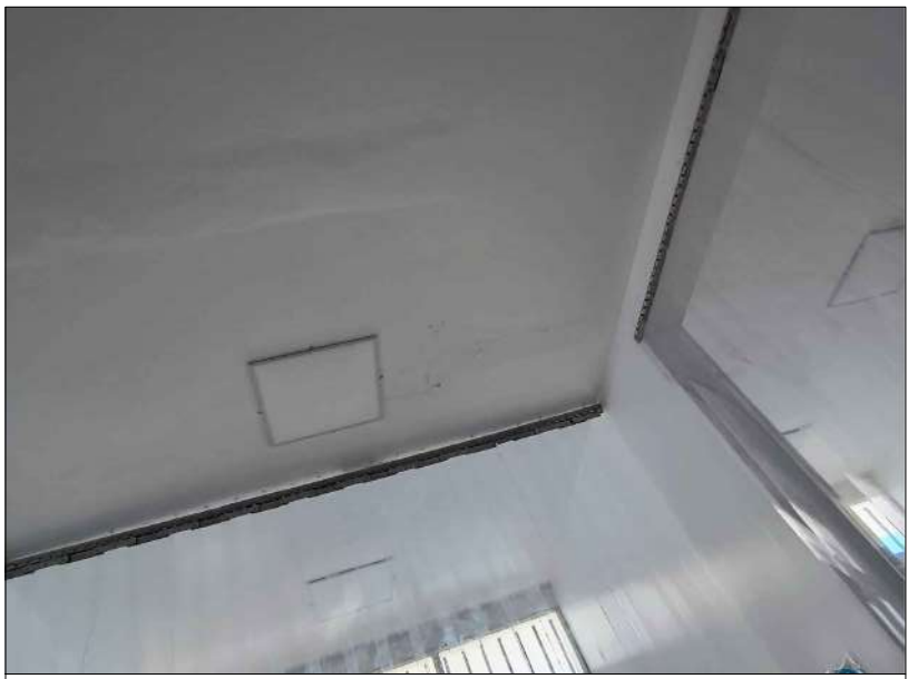
8 DESPRENDIMIENTO DE PINTURA EN CIELO RASO, DEBIDO A LA HUMEDAD ACUMULADA POR INFILTRACIÓN DE AGUA DE LLUVIA.
