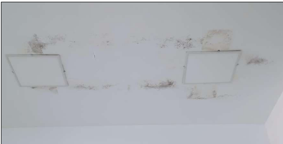
Imagen N°11: Aparición de moho y hongos en cielo raso.
