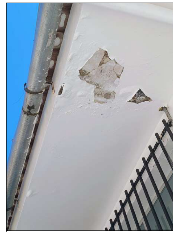
11 APARICIÓN DE MOHO Y HONGOS, Y DESPRENDIMIENTO DE PINTURA EN FALSO CIELO RASO DEBIDO A LA HUMEDAD ACUMULADA POR INFILTRACIÓN DE AGUA DE LLUVIA.
