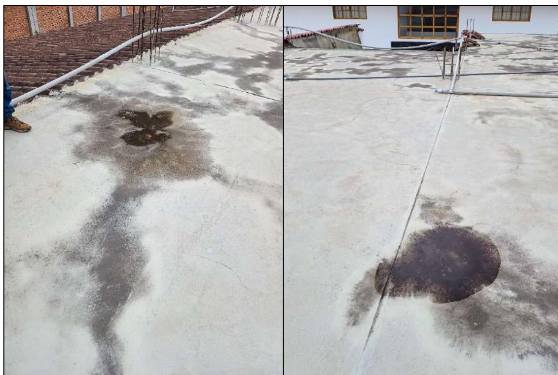
Imagen N°5 y N° 6: Zonas del techo con acumulación de agua de lluvia por falta de desnivel.
