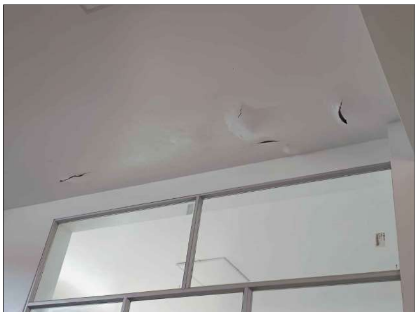
6 DESPRENDIMIENTO DE PINTURA EN CIELO RASO, DEBIDO A LA HUMEDAD ACUMULADA POR INFILTRACIÓN DE AGUA DE LLUVIA.
