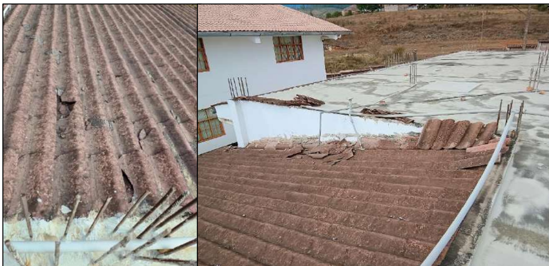
Imagen N°7 y N° 8: Cobertura de tejacreto en mal estado de conservación. Juntas entre cobertura y muro en mal estado.
