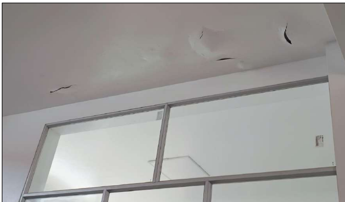
Imagen N°12: Desprendimiento de pintura en cielo raso.
