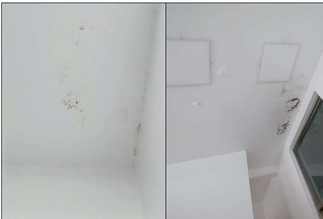
Imagen N°9 y N° 10: Aparición de moho y desprendimiento de pintura en cielo raso.
