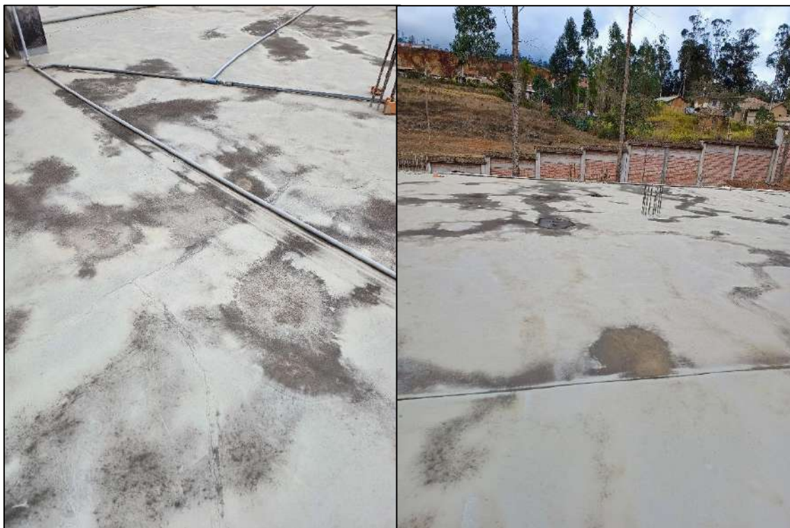
Imagen N°1 y N° 2: Presentación de moho por humedad en el techo.
