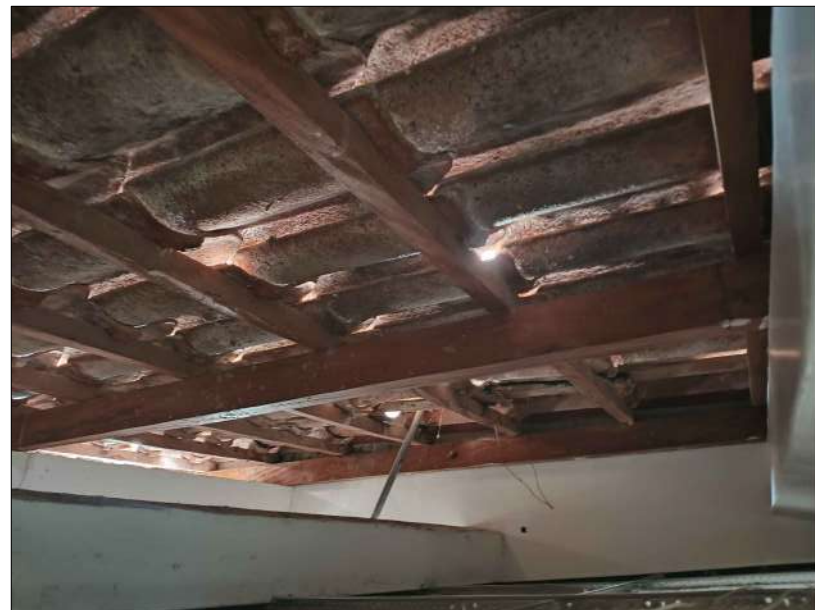
9 ESTRUCTURA DE APOYO DE COBERTURA EN ESTADO DEBIDO DEBIDO AL DETERIORO POR TIEMPO DE USO Y LAS CONDICIONES CLIMÁTICAS DE LA ZONA.
