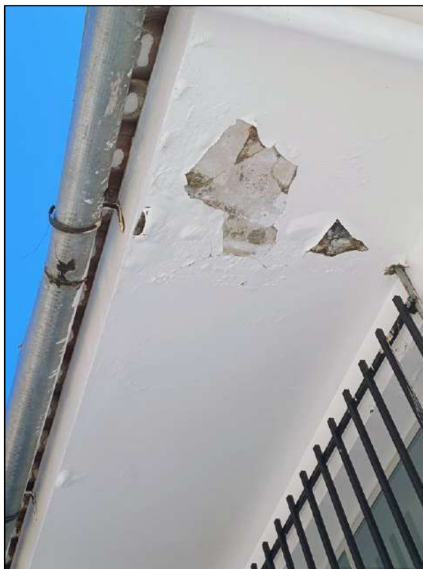
Imagen N°14: Desprendimiento de pintura en cielo raso.
