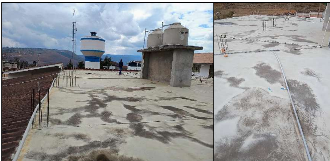
Imagen N°3 y N° 4: Presentación de moho por humedad en el techo.
