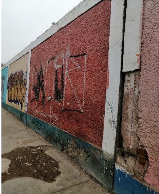
Imagen 03, 04: Se aprecia el desprendimiento de material de concreto y exposición del acero a la intemperie con oxidación.
