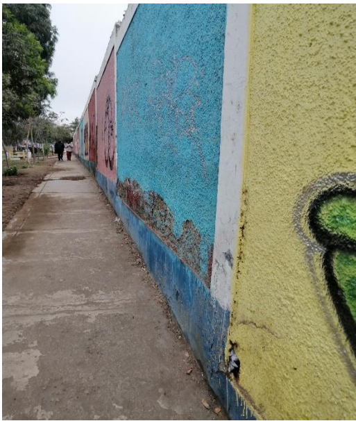
Imagen 03, 04: Se aprecia el desprendimiento de material de concreto y exposición del acero a la intemperie con oxidación.
