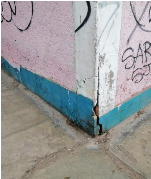
Imagen 03, 04: Se aprecia el desprendimiento de material de concreto y exposición del acero a la intemperie con oxidación.
