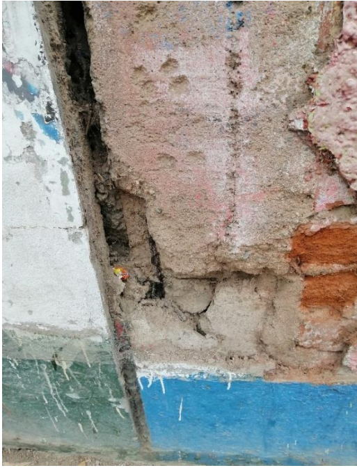
Imagen 03, 04: Se aprecia el desprendimiento de material de concreto y exposición del acero a la intemperie con oxidación.
