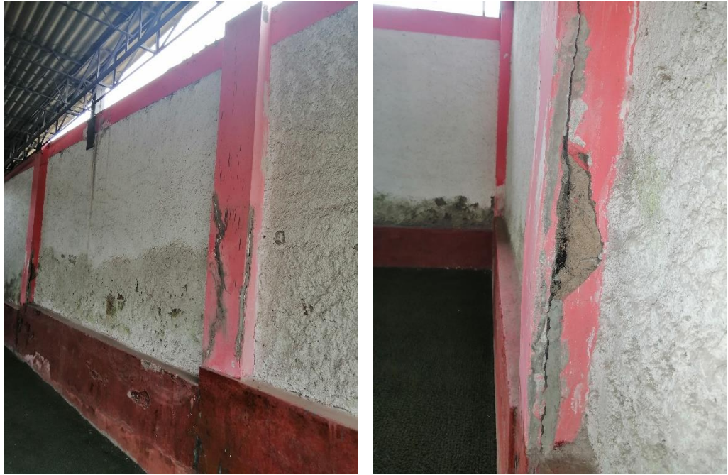
Imagen 09,10: Se aprecia el cerco perimétrico en el área de juegos por la parte interior, presentan grietas en columnas, exposición del acero a la intemperie y oxidándose, asimismo filtración de humedad en columna, sobrecimiento, y muros de albañilería.
