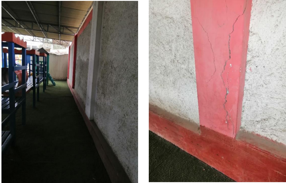
Imagen 11, 12: Se aprecia fisuras diagonales en columna de concreto, así como la filtración de humedad en columna, sobrecimiento, y muros de albañilería.
