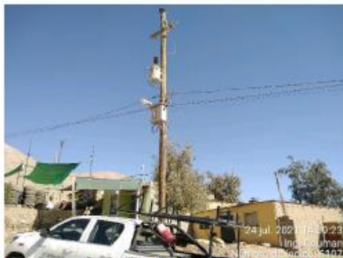
Redes Primarias en El Pozo en mal estado de conservación.
