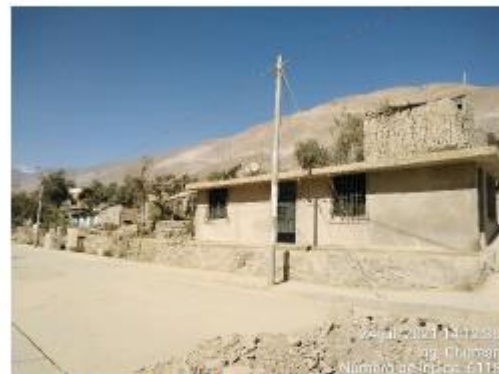
Retenidas sin aislar en la localidad del Poozo.
