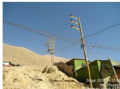
Instalacion de SED en la localidad de Mollehuaca en terreno inestable.
