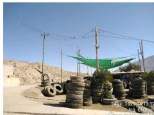
Redes Secundarias en la localidad del Pozo con incumplimiento de DMS.
