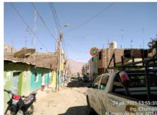
DMS de conductores respecto a límite de propiedad de viviendas en Relave.
